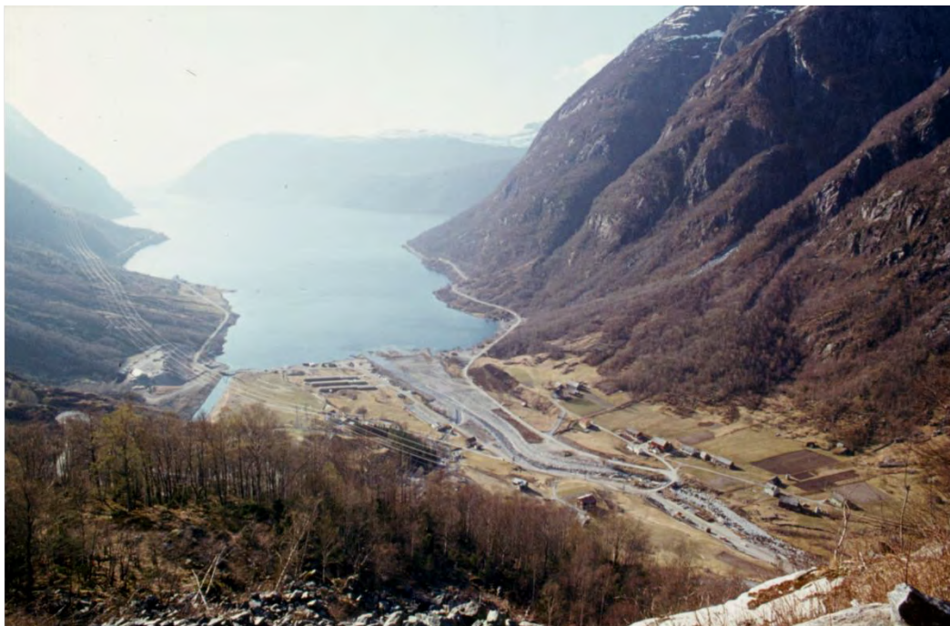
Figur 13-3 Austrepollen 1974. Her ser en hvordan elleviften har blitt samlet i et kunstig løp, og utløpstunnelen er blitt anlagt til venstre (sør for gården Gjerde). Fotograf: Knut Ove Hillestad/NVE.
