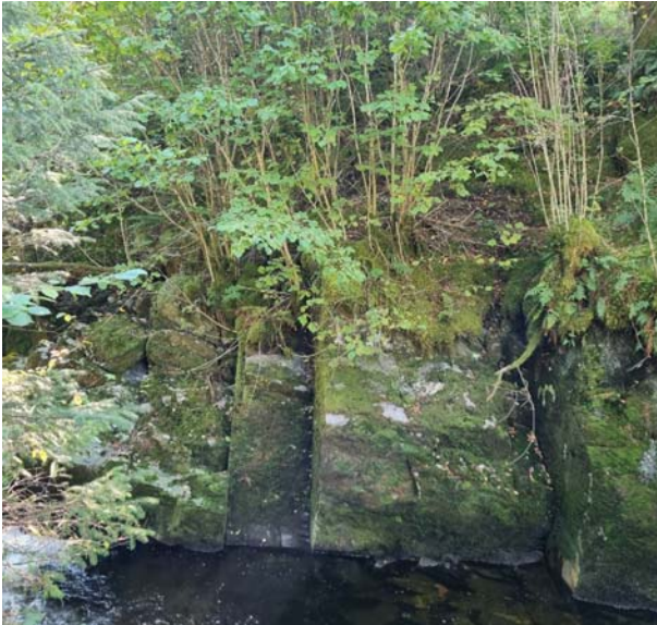
Bilde 8: Der elveløpet er på det smaleste er det berg i dagen på begge sider av elveløpet.
