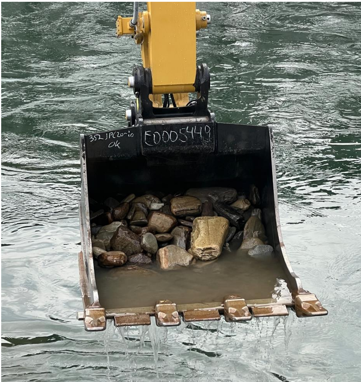
Bilde 1 viser grusmasser fra prøvegraving i elv ved pilar 3 for jernbanebru
