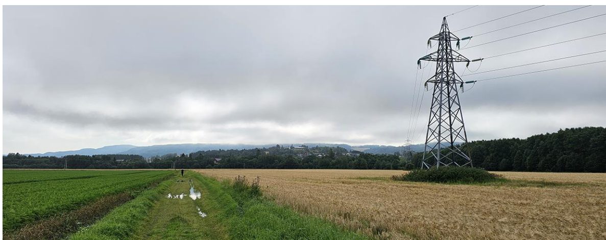
Bilde 9-1: Bilder av ulike master inn i jordbrukslandskapet som blir influert av tiltaket. Selv om en komposittmast vil ha helt andre dimensjoner enn masta i det øvre bildet vil størrelse være relativ i forhold til betrakters avstand. En enkel mast med mindre industrielt preg passer godt til landskapsbildet.
