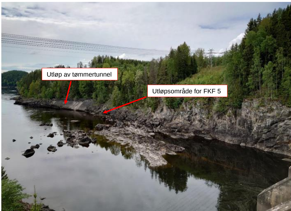
Figur 7 Strekingen nedstrøms eksisterende dam/flomløp (Bilde: Norconsult)
