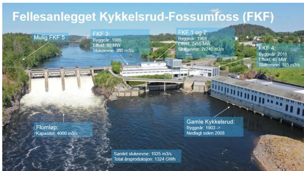
Figur 2 Eksisterende kraftverk med overløp over dammen. Et mulig FKF 5 vil bli bygget på vestsiden av elva og dagens anlegg.
