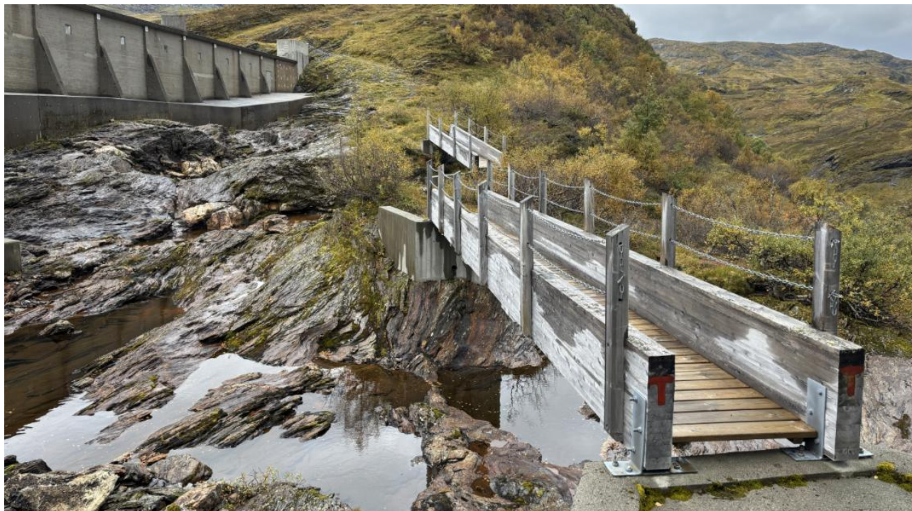
Figur 3-9: Eksisterende gangbroer nedstrøms overløpsdammen, sett mot sør.
