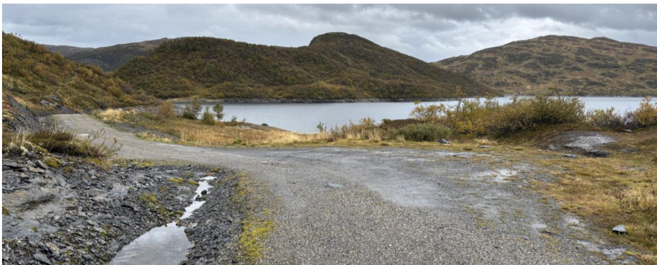
Figur 3-19: Snuplass 2 rett sør for strekningen av anleggsveien som skal heves (nr. 6 i Tabell 3-1).
