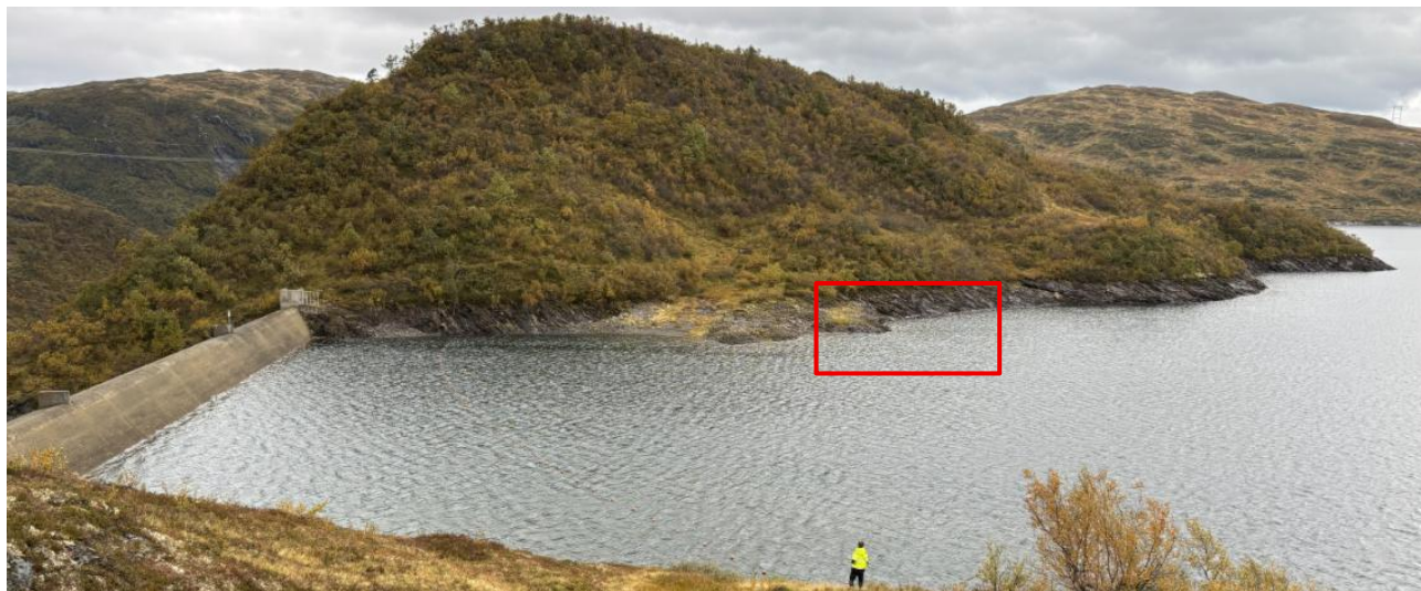
Figur 3-5: Oppstrøms overløpsdammen Målsetvatn. Lokalisering av planlagt inntak vist i rødt. Ved vannstanden på bildet vil inntaket ikke være synlig.
