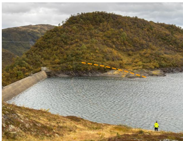
Figur 3-16: Traséer av midlertidig anleggsveier vist med oransje stiplede linjer. Adkomst til utløp nedstrøms overløpsdammen, gangbroene må rives og erstattes (venstre). Adkomst til lukesjakt og -hus, nøyaktig plassering skal fastslås basert på stedlige vurderinger ved oppstart av anleggsfasen (høyre).
