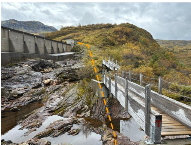
Figur 3-16: Traséer av midlertidig anleggsveier vist med oransje stiplede linjer. Adkomst til utløp nedstrøms overløpsdammen, gangbroene må rives og erstattes (venstre). Adkomst til lukesjakt og -hus, nøyaktig plassering skal fastslås basert på stedlige vurderinger ved oppstart av anleggsfasen (høyre).
