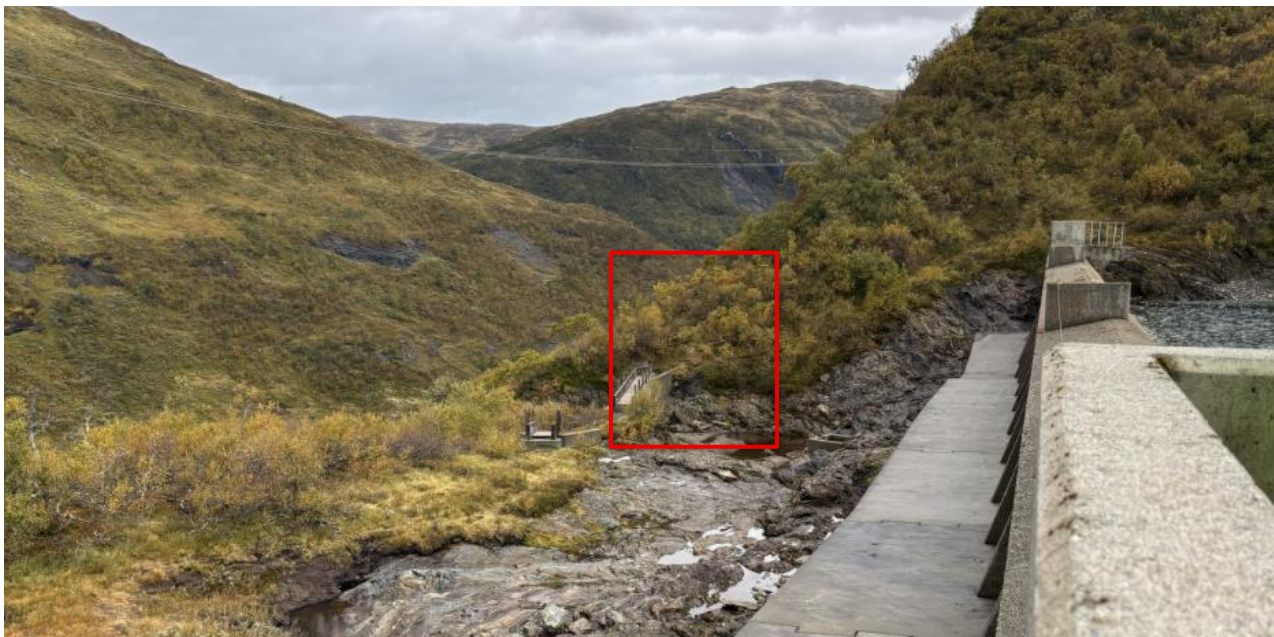
Figur 3-7: Nedstrøms overløpsdammen Målsetvatn, lokalisering av påhugg til utløp vist i rødt.
