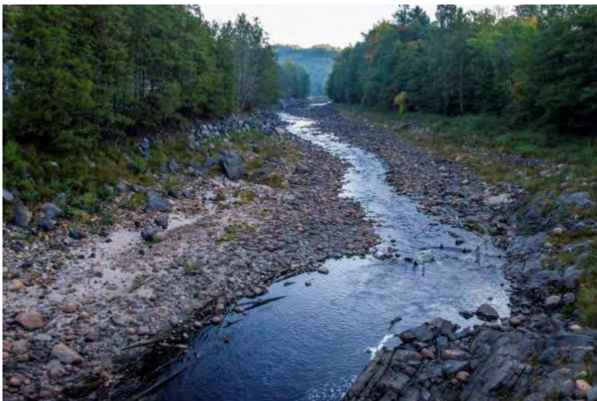
Figur 6: Gjerstadelva den 16.09.2020. Bildet tatt fra bilbrua ovenfor Søndeled dam og viser elva opp mot Brøbøvann. Bildet er hentet fra Rådgivende Biologer AS, Notat 07.10.2020. Vannføringen 16.09.2020 er estimert til 1 m 3 /s. Vannstand ved fullt magasin er rett under trevegetasjonen.
