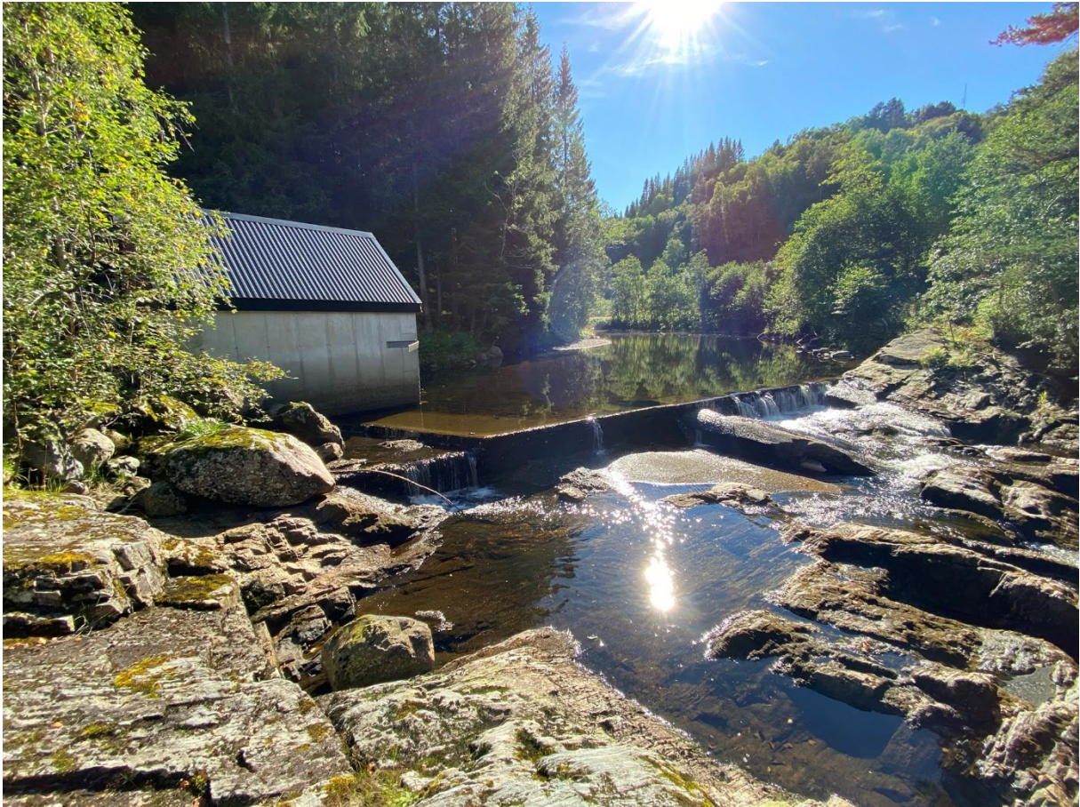
Figur 2-4 Dam og inntaksted før utbygging med betongterskel og inntak til fiskeoppdrettsanlegget til Lerøy Midt AS.
