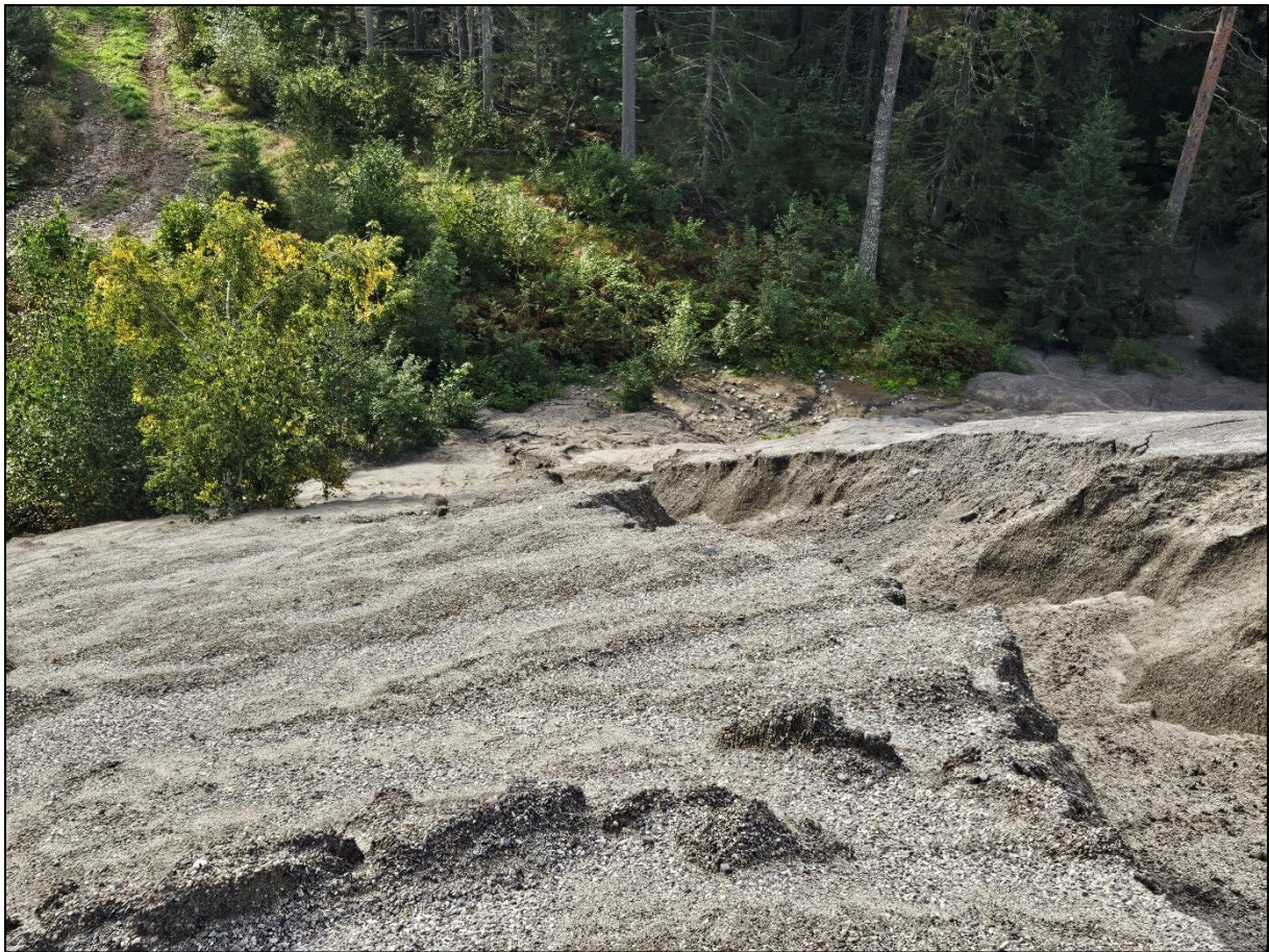
Figur 7: Utglidning i opparbeidet terreng/fylling av finkornede sorterte masser. Bildet er tatt helt sør i kartleggingsområdet, øst for Trongedal.
