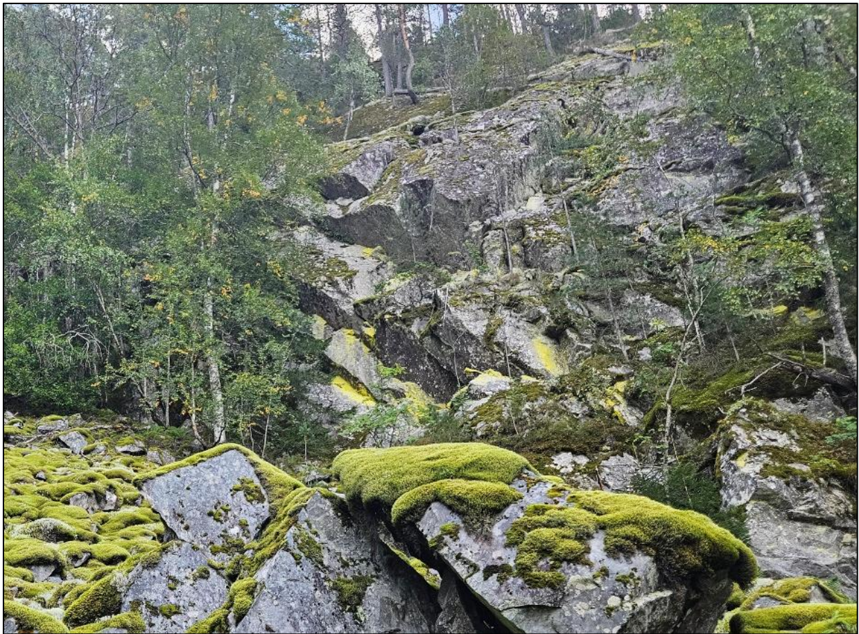
Figur 5: Bildet er tatt ved uravsetning på nordsiden av Gammelstulkåsnatten. Sprekker i berget ovenfor ses tydelig.
