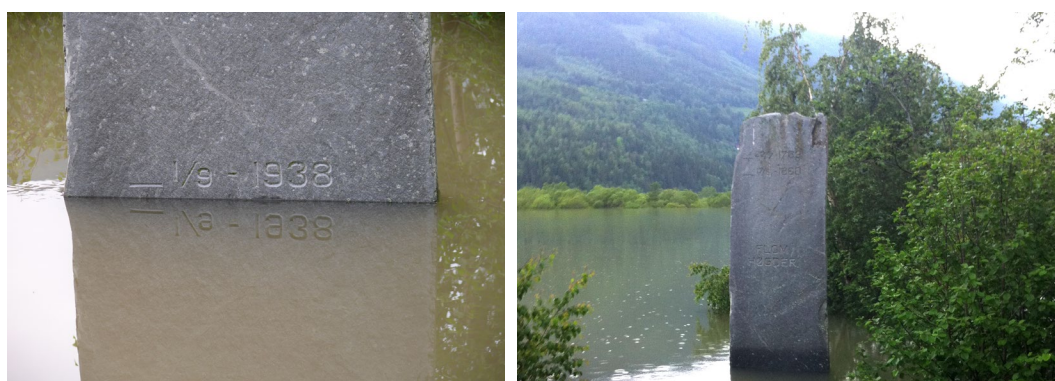
Figur 2-9: Vannstand ved flomstøtten på Lalm 10. juni 2011. Venstre bilde tatt ved kl 19 og bilde til høyre tatt senere på kvelden. Foto: Øyvind Armand Høydal (NGI)
