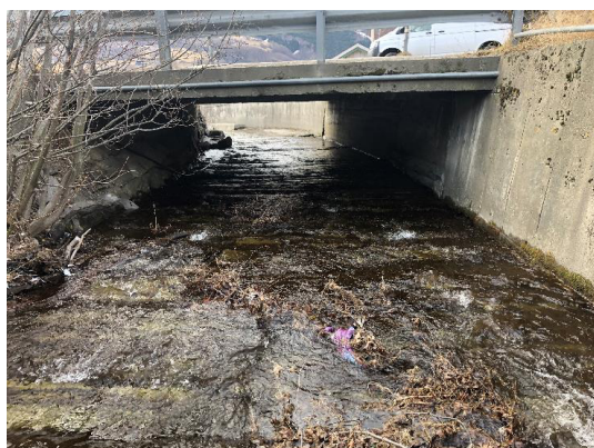
Nugga, kjørebro Vågåveien oppstrøms
