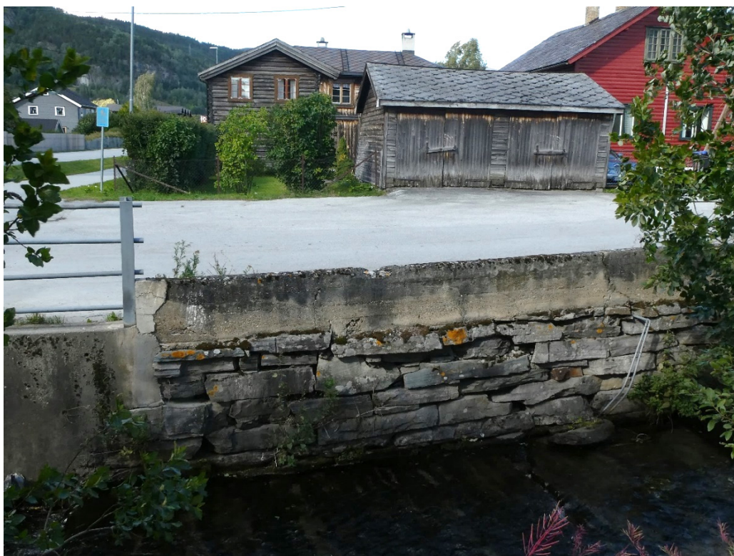
Figur 8-6 Foto av vertikale murer ved Nugga nedenfor Trafostasjonen. Elveforbygningene er ikke statlig listeført, men verneverdige. Foto: NIKU, august 2021.
