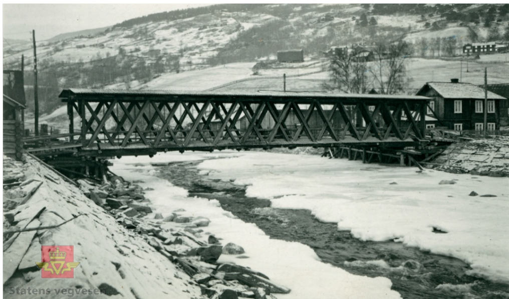
Figur 8-5 Foto fra 1937 av murte, avskrånede elveforbygninger langs Finna, ved den daværende Finnbrua. Foto: Norsk vegmuseum, tilgjengelig på www.digitaltmuseum.no
