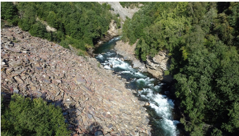
Figur A - 15 Dronebilde tatt litt lengre sør enn bildet vist i figur 1 7. Løsmassene består hovedsakelig av avfall fra skiferutvinningen lengre opp i skråningen. Bildet er tatt mot nord-vest. Lokalisering er vist i Figur A - 1.
