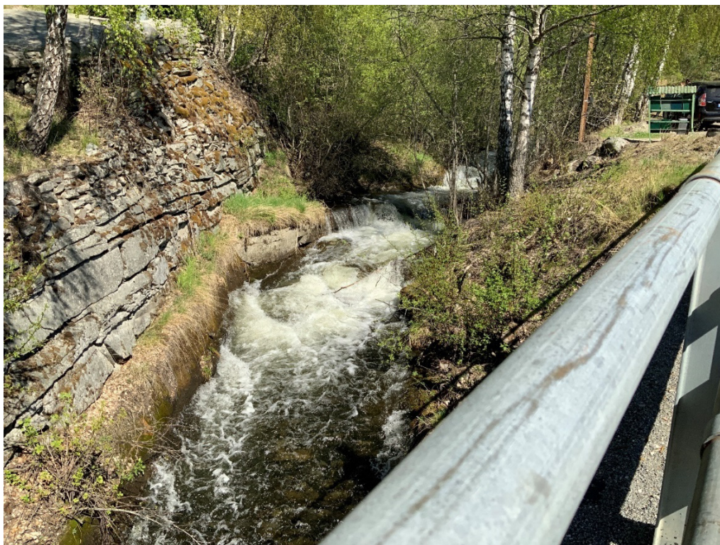
Figur A - 25 Nugga sett oppstrøms fra bilbrua på Øygardsvegen ved punkt 16. Lokalisering er vist i Figur A - 1.
