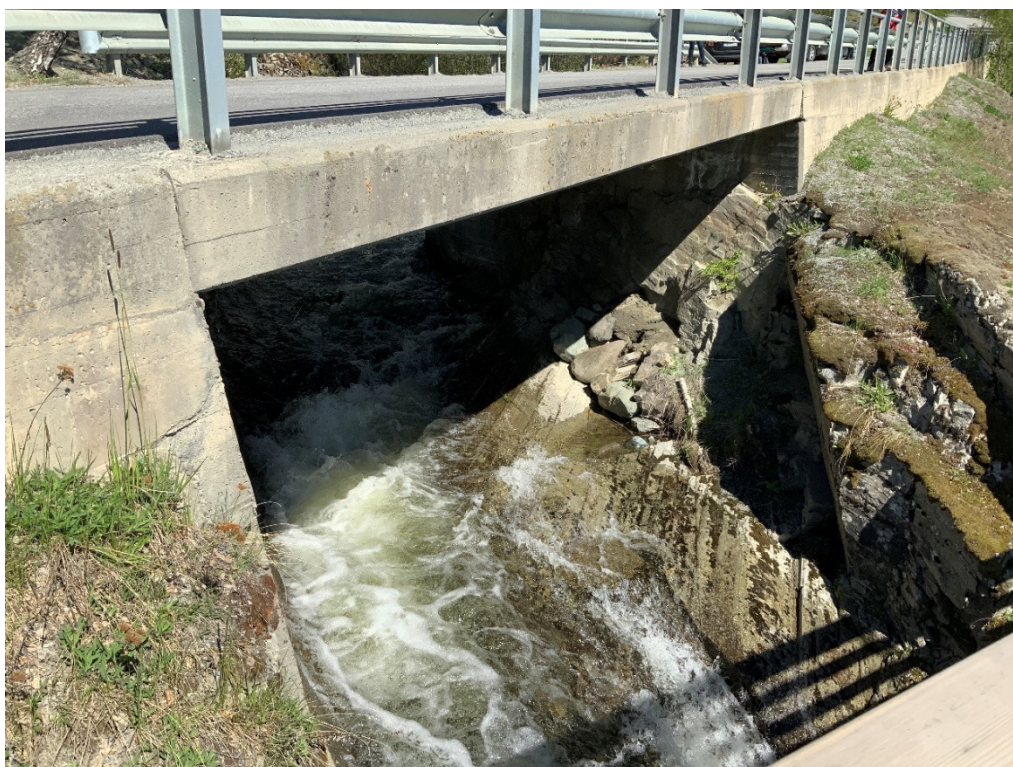
Figur A - 27 Bilbrua sett fra tilkomstbrua til Øygardsvegen 11. Lokalisering er vist i Figur A - 1.
