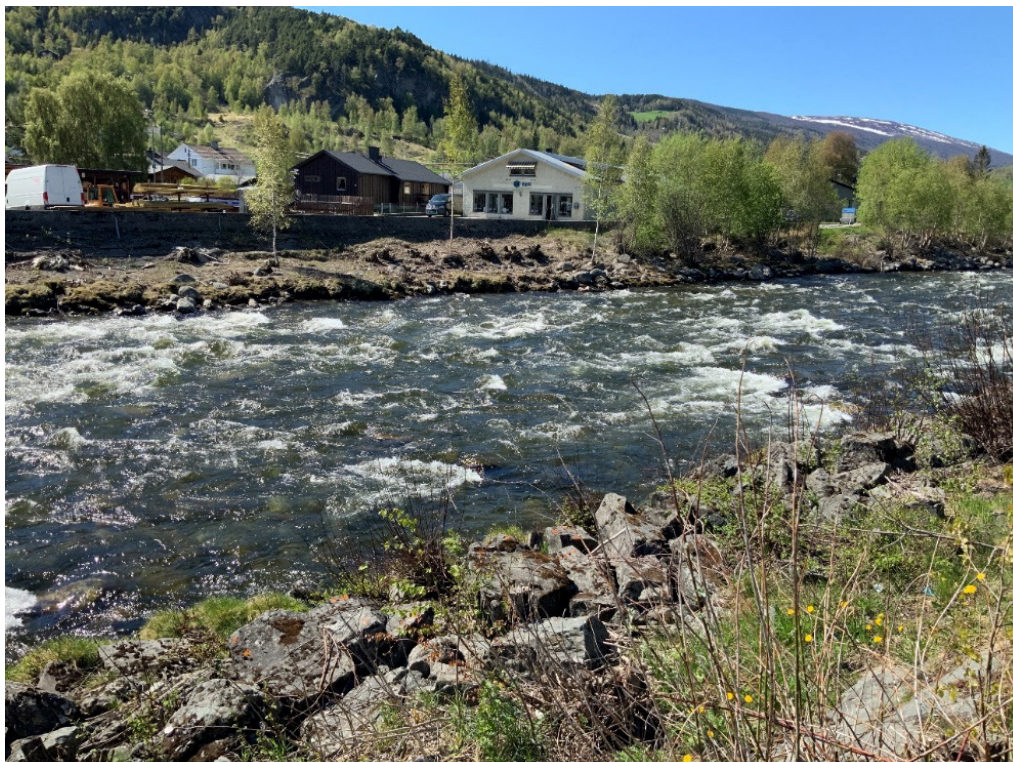
Figur A - 7 Elveløpet rett oppstrøms Finna bru. Bildet er tatt fra øst mot vest og viser elveløpet med tilhørende erosjonssikring. Lokalisering er vist i Figur A - 1.
