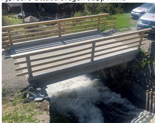
Nugga, Øygardsvegen nedre kjørebro
