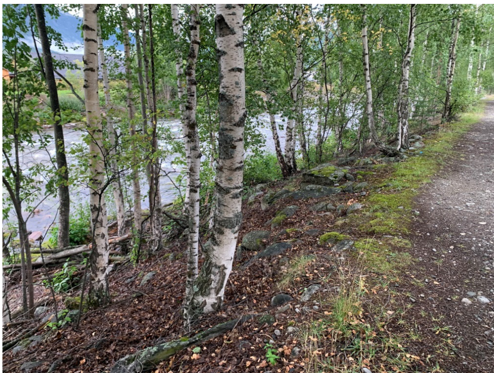
Figur A - 5 Sør for Vågå kirke er det anlagt en flomvoll bestående av grov stein. Bildet er tatt fra nord mot sør. Lokalisering er vist i Figur A - 1.
