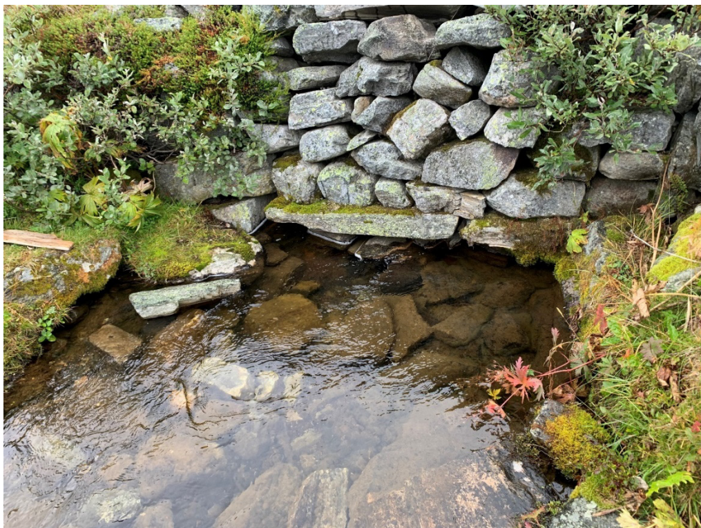
Figur A - 39 Utløp under dam ved Jettjørne. Bildet er tatt nedstrøms dammen fra sør-vest mot nord-øst. Lokalisering er vist i Figur A - 1.
