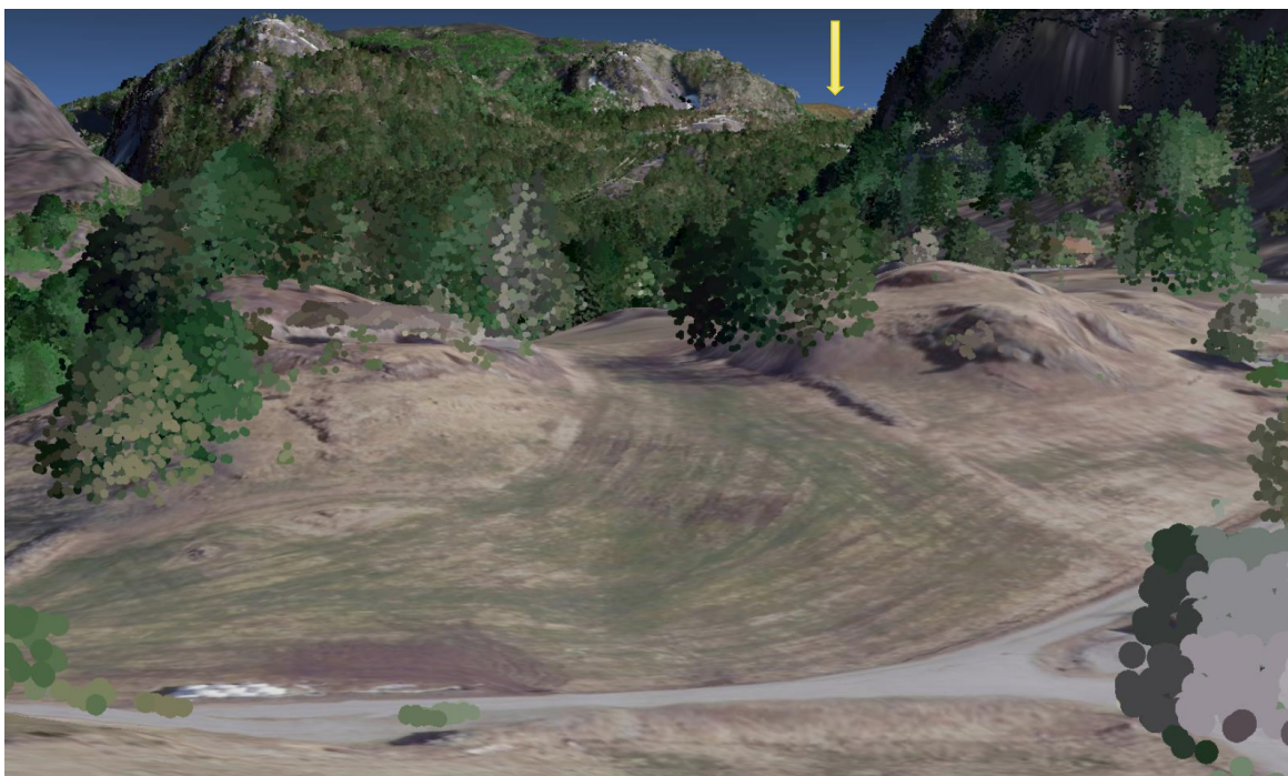
Figur 3-25 Deponi Tverrdalen A er synlig på modell helt fra bebyggelsen ved Jordebrekk. Deponiet burde vært redusert i størrelse for å være mindre synlig i landskapet.
