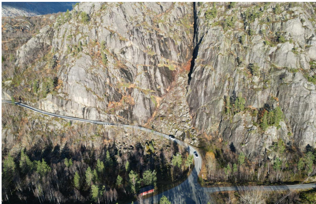
Figur 3-16 Dronebilde fra Svinsenuten. Deponi er tenkt til venstre i bildet, nederfor veien. Påhugg til tunnel er tenkt i fjellveggen nede til høyre i bildet.
