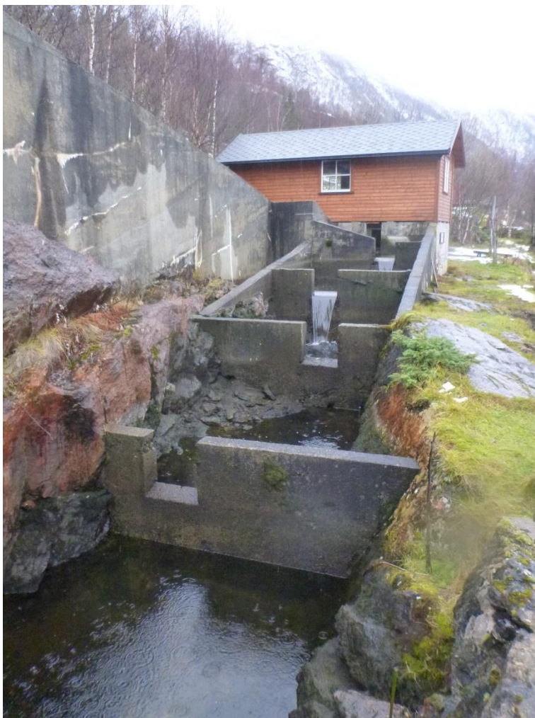
Figur 12. Laksetrappa i Forsåfossen. På bildet er trappa stengt for vinteren. Foto: Kjetil Sandem, Norconsult.
