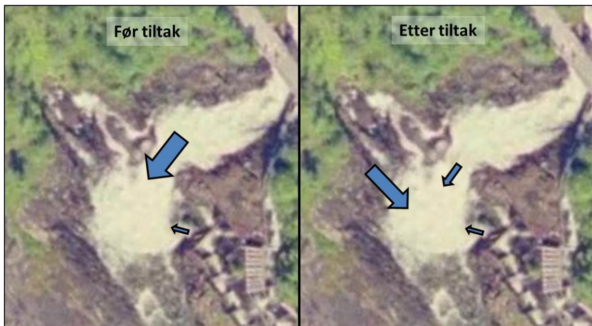
Figur 23. Vannveier ved Forsåfossen før og etter tiltaket.
