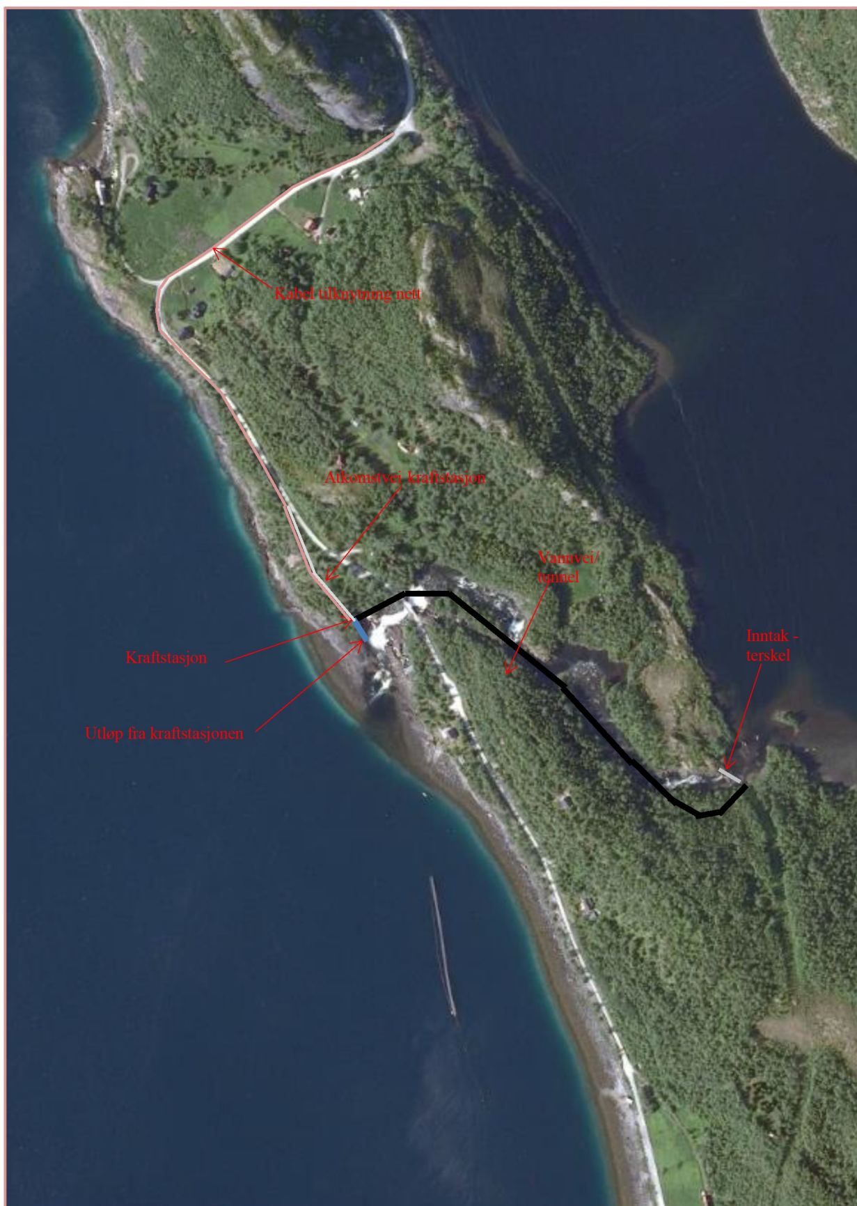
Oversiktsbilde(fra Norge i3D) – hovedelementer i kraftverk
