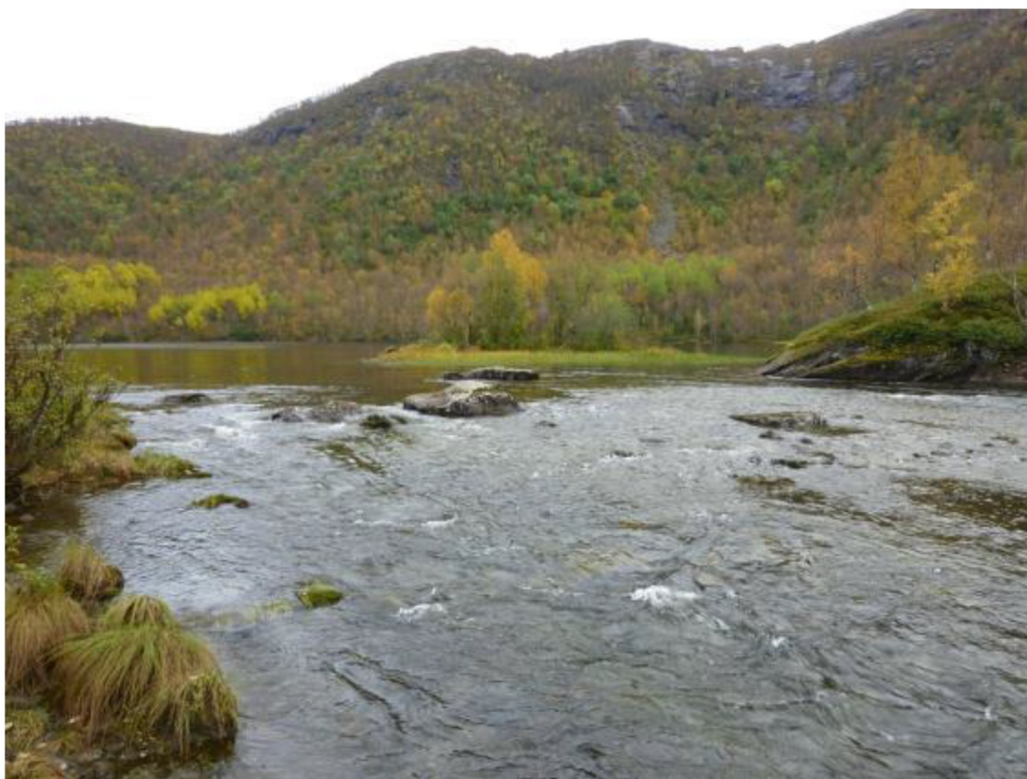
Fra terskel/dam sett oppover – vannspeil løftes herfra opp til utløpet av vannet
