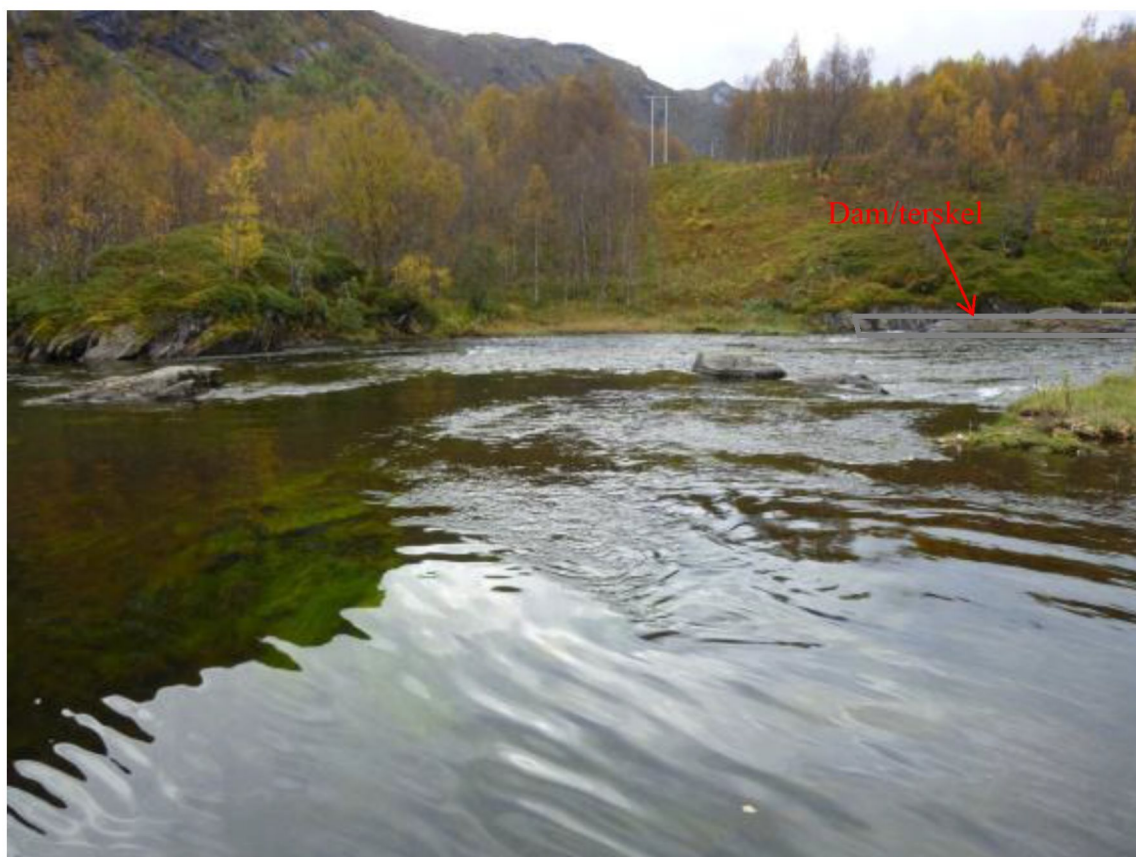
Oversiktsbilde utløp med terskel/dam
