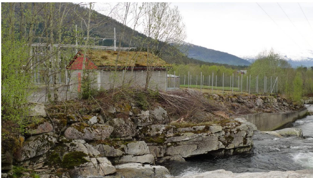
Figur 2-4: Bilde av Tomasgard transformatorstasjon, tatt mot sørvest
