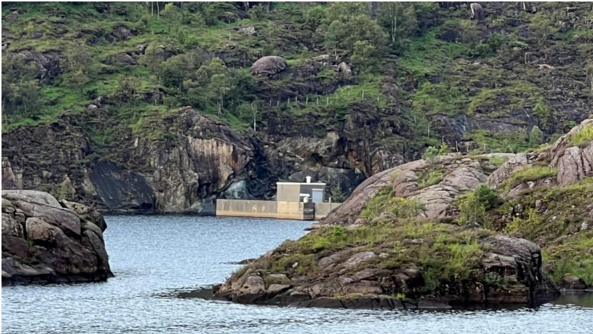
Inntaksdam Honnefoss med inntaksmagasinet til Honnefoss. Nytt inntak under kolle i forgrunnen av dam.
