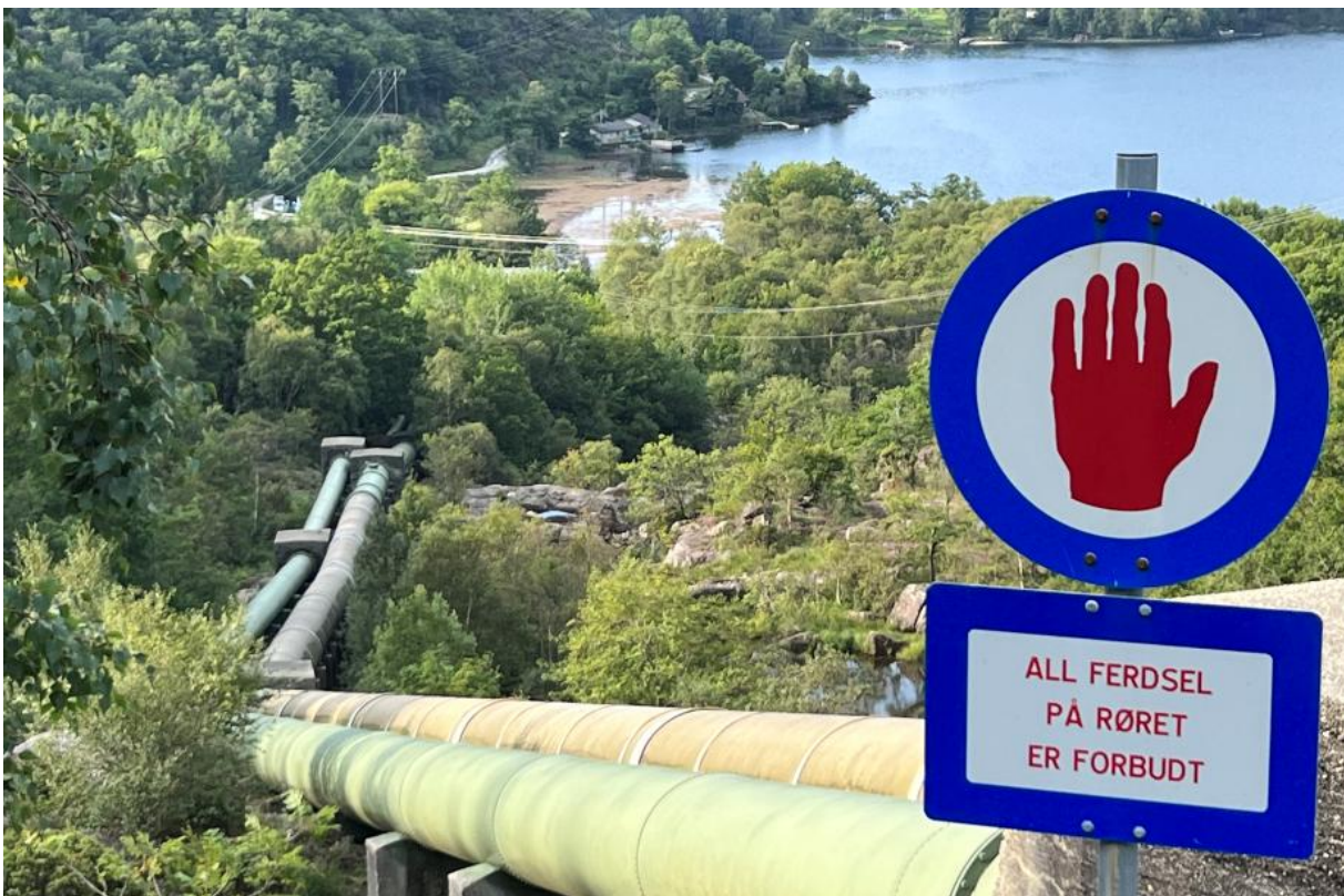
Vannvei i dagen. Rør og fundamenter vil bli revet og fraktet til godkjent mottak.
