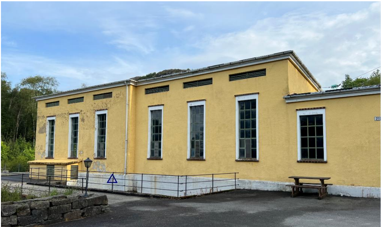
Grødemfoss kraftstasjon vil bli revet. Vei til ny kraftstasjon vil gå over tomta og mot venstre kant i bildet.
