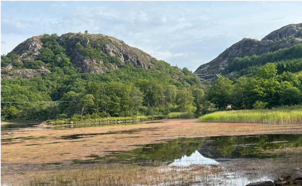
Grødemfoss kraftverk – utløp i Svåvatnet til høyre for odde. Nytt utløp vil være til venstre for odde.
