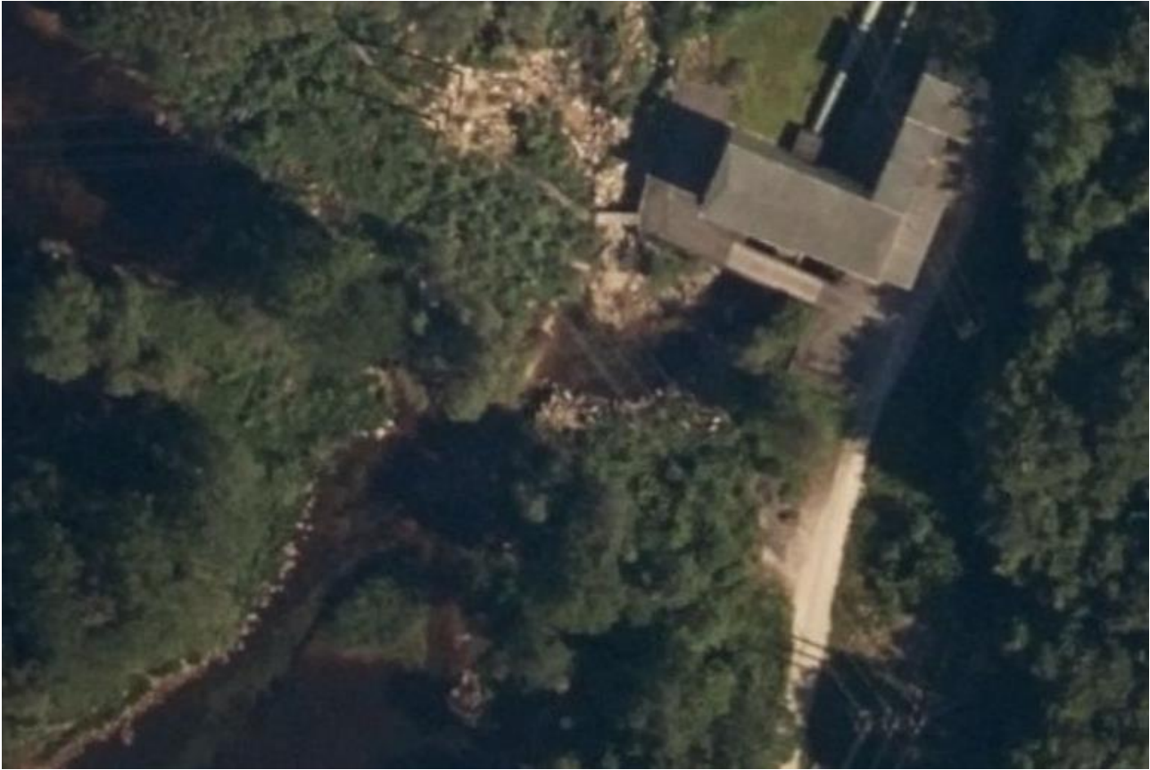
Figur 7. Utløpsområdet sett fra luften. Bildet viser en høyere vannstand i utløpsområdet enn dert var under befaringen. Kilde: norgebilder.no
