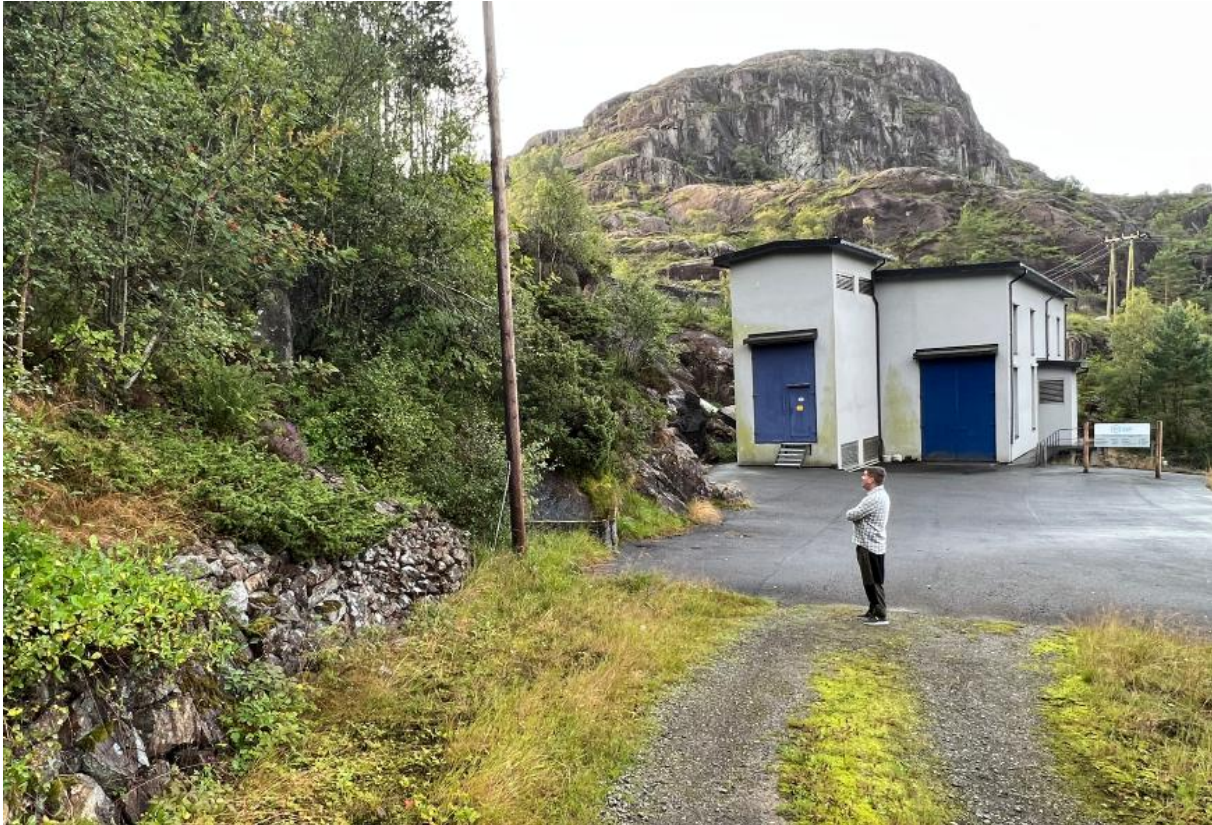
Honnefoss kraftstasjon. Ny kraftstasjon plasseres omtrent der personen står.
