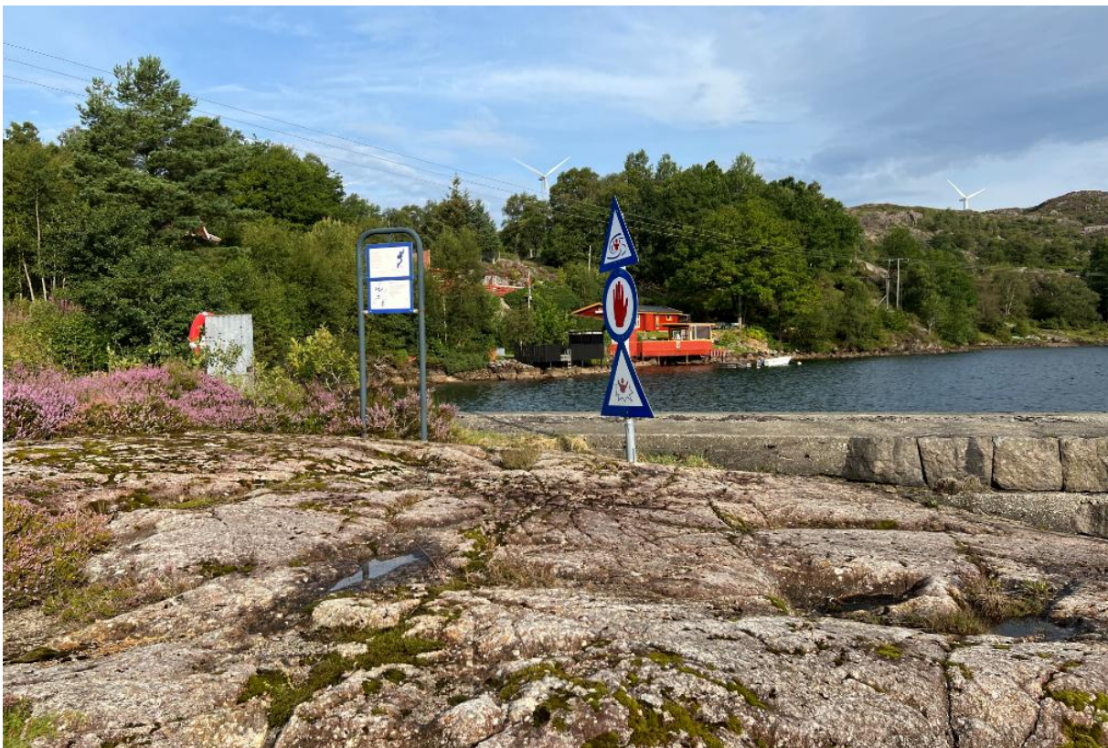
Dam Smievatn. Ålepassering -oppgang - vil trolig gå opp langs dammen på denne siden og over.
