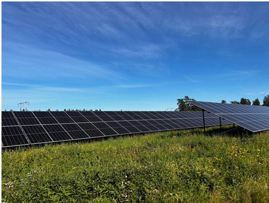
Figur 4 – Solcellepaneler montert i portrett.
