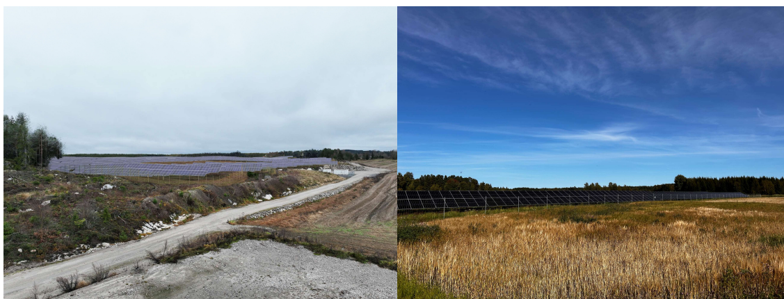
Figur 9 – Inngjerding av solkraftverk.
