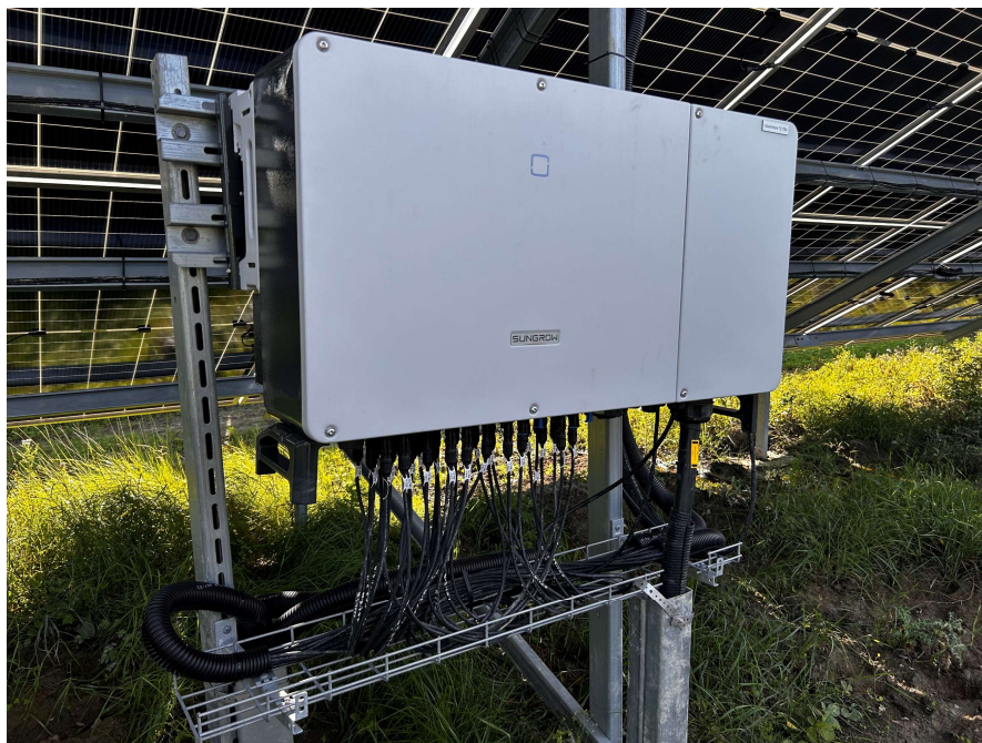
Figur 5 – Vekselretter montert på festestruktur.
