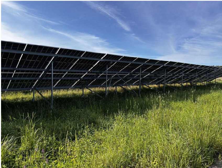
Figur 7 – Montasjesystem for solcellepaneler.
