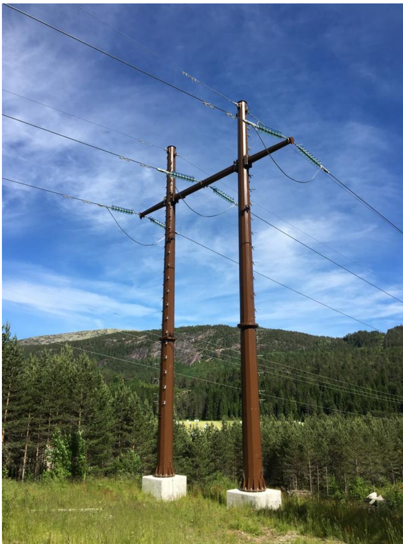
Figur 2-10: Stålrørsmast her vist som H-mast med toppliner. Benyttes i vinkler og/eller der det ikke er ønskelig med bardunering.
