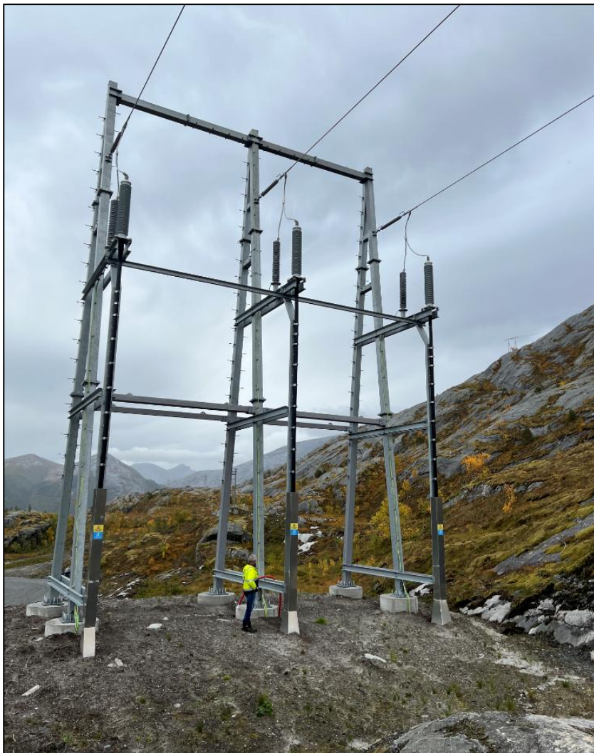
Figur 2-9: Kabelendemast i stål. Benyttes i overgangen mellom luftlinje og jordkabel.
