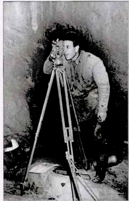
Foto 1: A. Sommerli i arbeid på Røssåganlegget.
