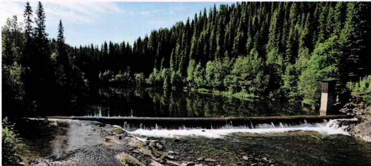
Foto 9 Terskel og målestasjon i Røssåga, ovenfor Sjøforsen.
