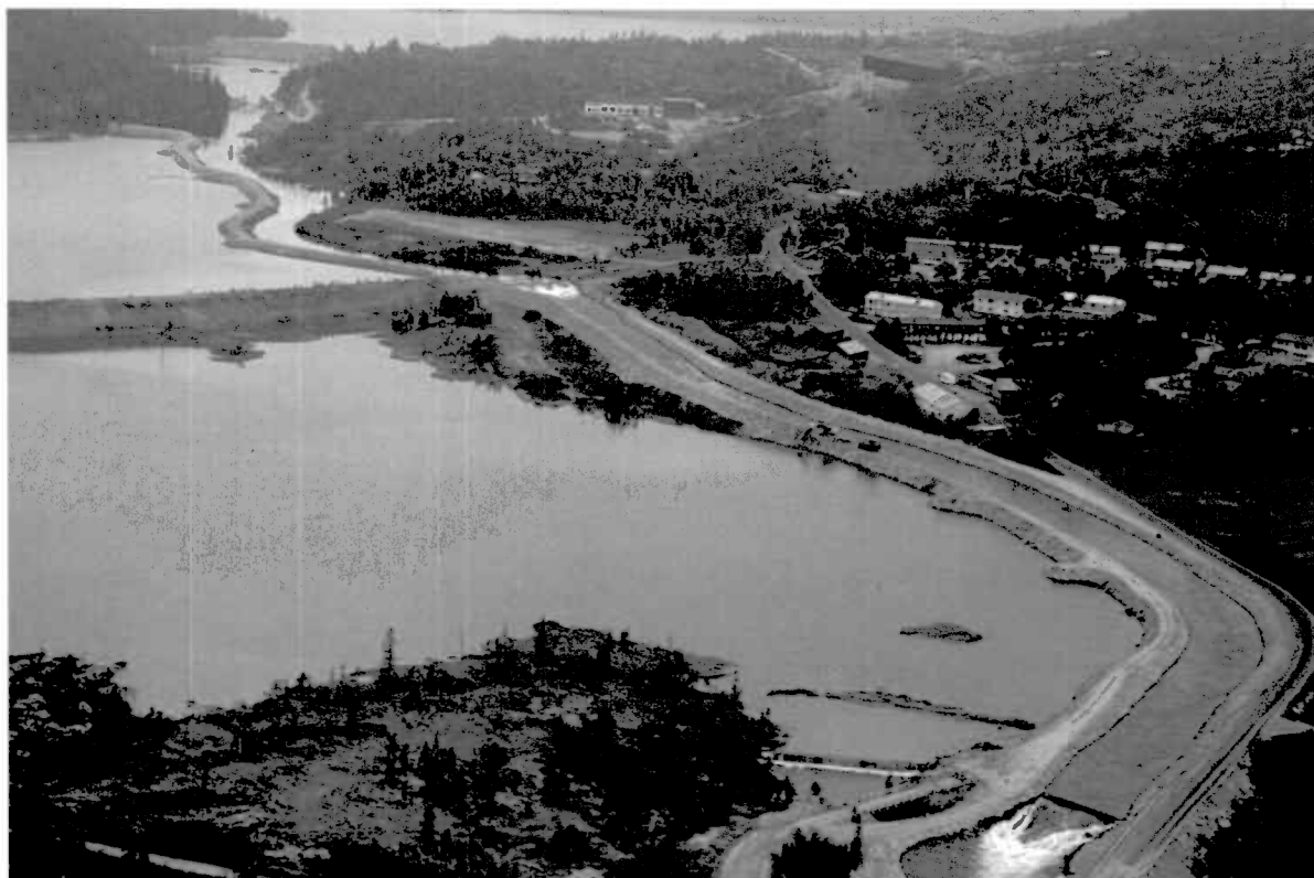
Foto 12 Flyfoto av flomkanalen i Lille Bleikvatn med de vanndekte gruvedeponiene til venstre i bildet.
