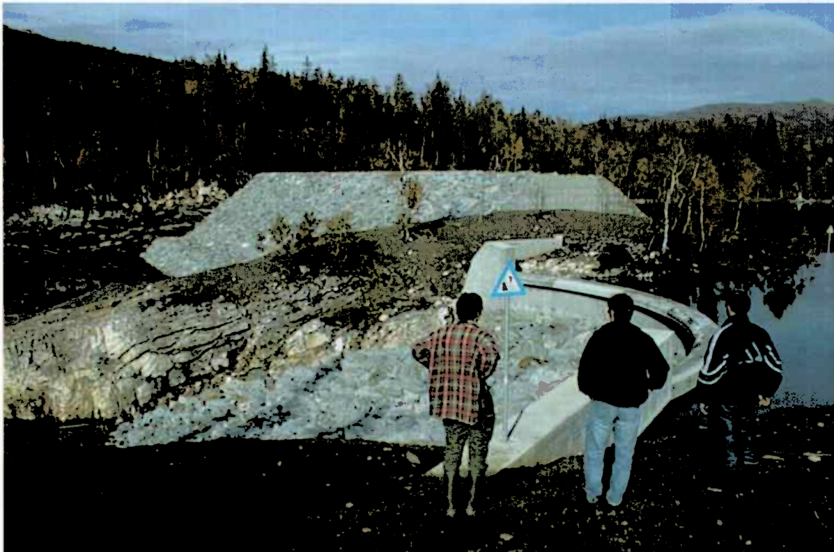
Foto 3 Bleikvassdammen. Steinfyllingsdam og overløpsterskel
