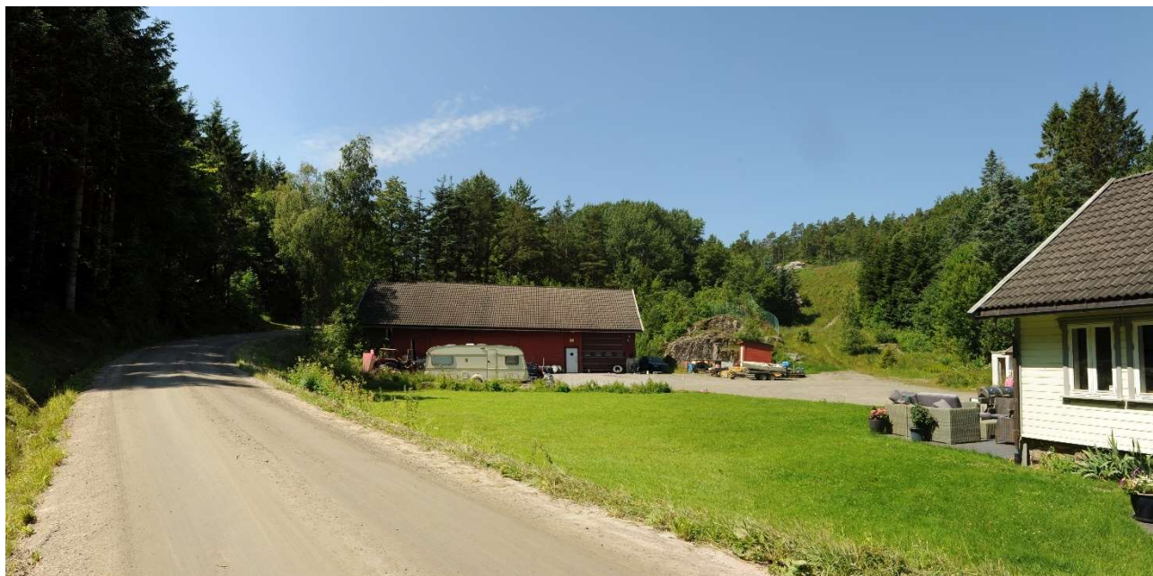
Figur 6-62. Bilde av dagens situasjon ved Skoieveien. Veifylling fra nye E39 er synlig mellom trærne til høyre i bildet.
