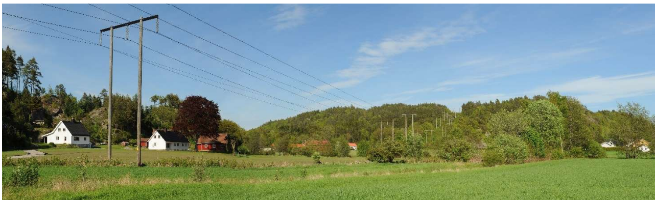
Figur 6-26. Dagens ledning gjennom det åpnet jordbrukslandskapet ved Berge (visualisering 8).
