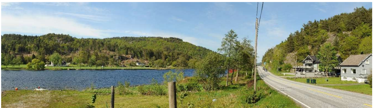
Figur 5-32. Mandalselva. Marnaveien til høyre i bildet.
