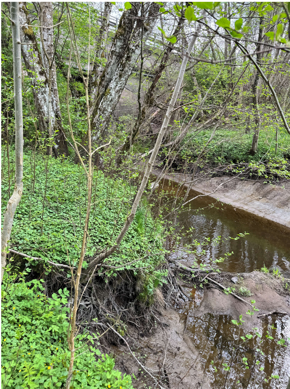
Figur 6-11: Område 3. Borgebekken retning sørover ved Østre Åmodt bru [bilde tatt 06.05.24].
