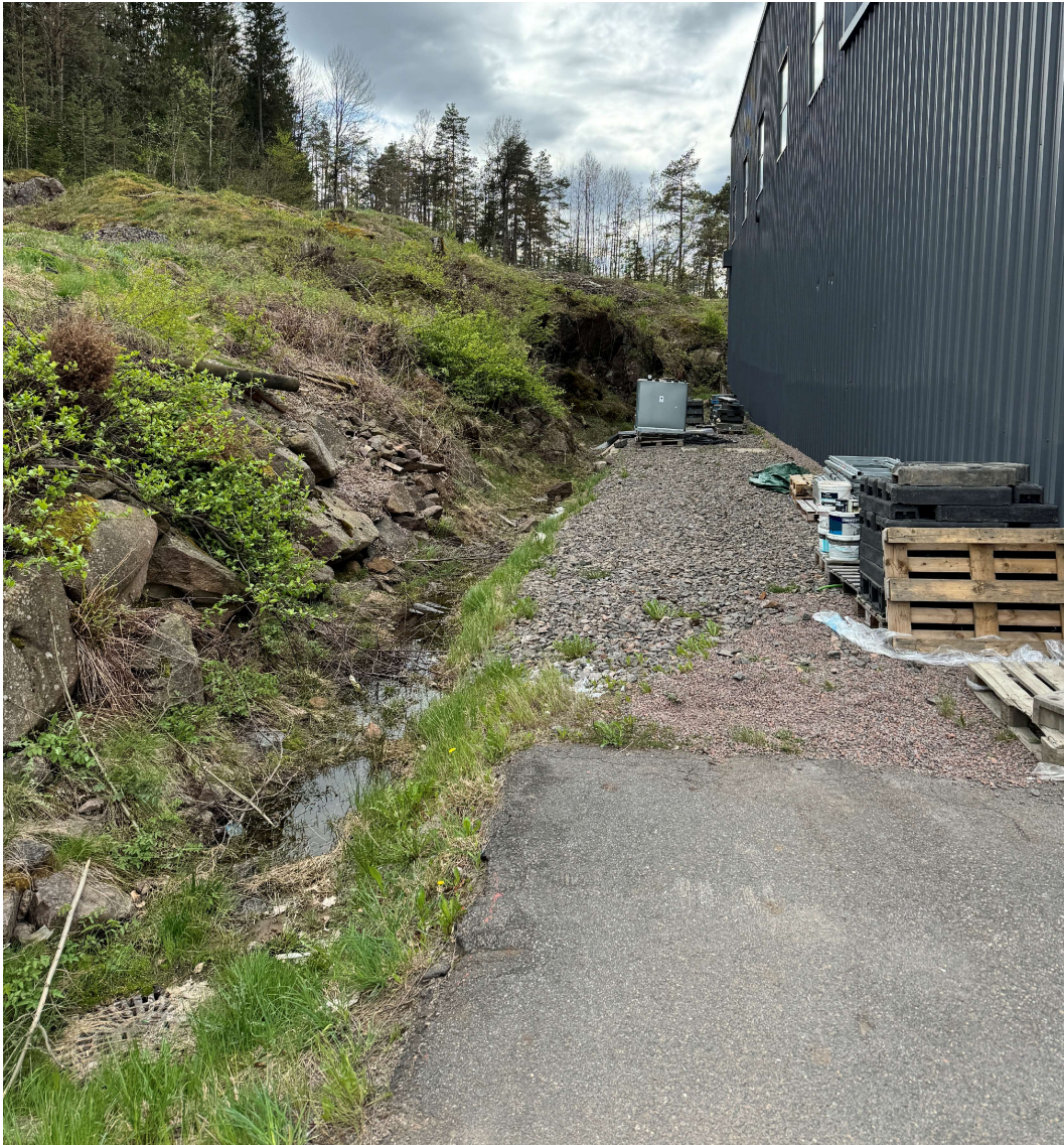
Figur 6-14: Område 4. Berg i dagen på sørsiden av stasjonstomta [bilde tatt 06.05.24].
