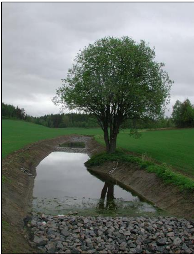
Figur 18. Bekkeåpning med energidrepende tiltak (fangdam)
