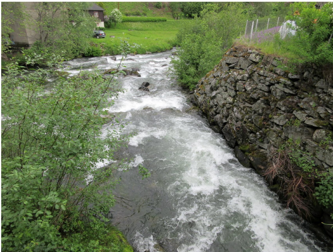
Bilde 2: Bilde tatt fra utløpet fra kraftverket med kraftverket i drift
