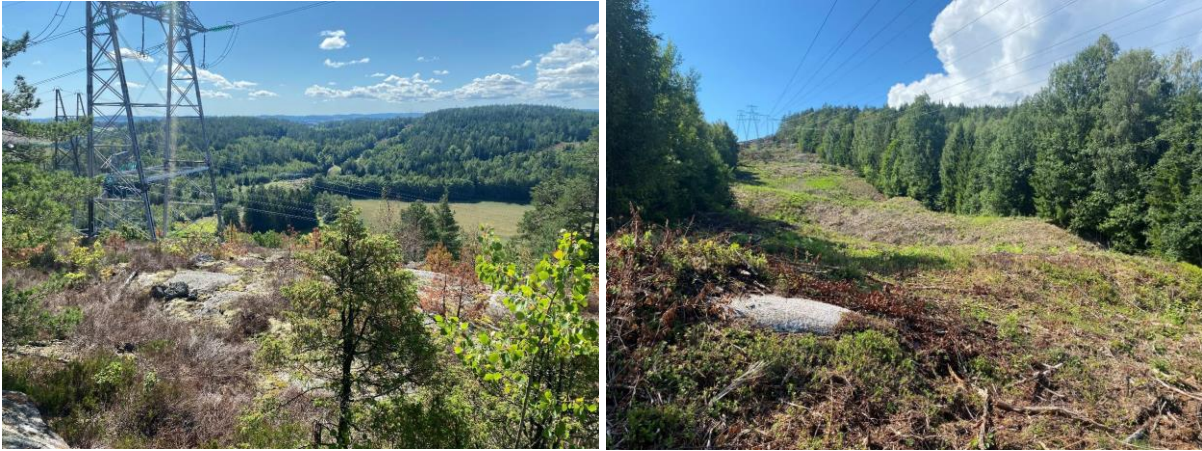
Figur 3. Foto fra søndre del av Undrumsdalsåsen mot Gulliåsen i bakkant (venstre). Bildet er tatt mot sør med planlagt område for transformatorstasjon midt i bildet i bakgrunnen. Høyre bilde viser nylig ryddet kraftgate ved Gulliåsen. Foto: Sweco Norge.
