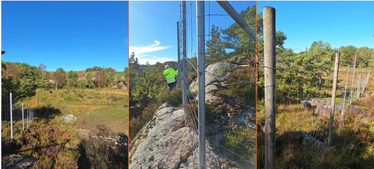
Fig. 3. En komplett visuell inspeksjon av gjerdets perimeter ble gjennomført, og gjerdet ser ut til å være i god stand. De galvaniserte stålplåene viser ikke tegn til korrosjon, og enkelte steder på gjerdet er det brukt trepåler.
