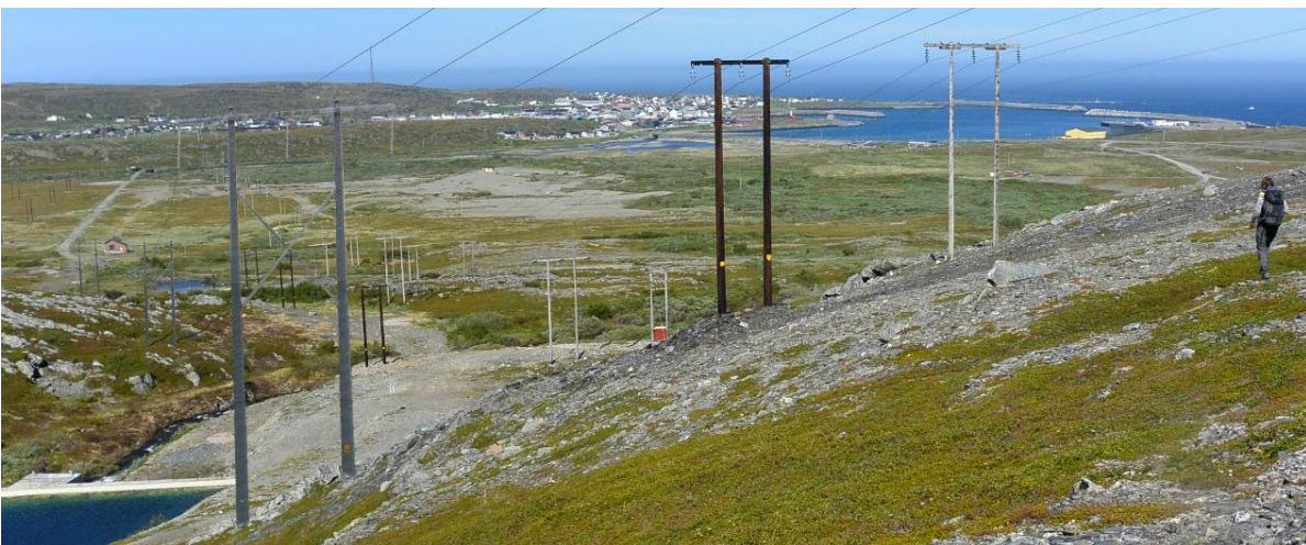
Figur 16 med bilde tatt ovenfor demningen, ned mot Berlevåg og viser at den visuelle virkningen av tiltaket, vist på manipulert bilde nederst for alternativ 1, skiller seg noe fra eksisterende situasjon, vist ovenfor. Virkningen vil være størst for de mastene som til enhver tid er i umiddelbar nærhet.
