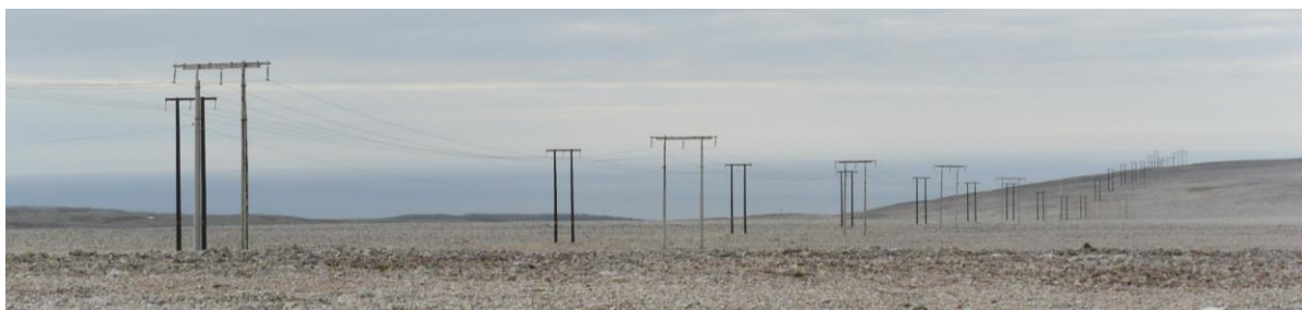
Figur 5. Eksisterende masterekker over Løkvikdalsfjellet. Gammel 66 kV mast i lysna kreosot til høyre, ny 22 kV i fersk, mørk kreosot til venstre. Inngrep i form av ryddegater vil ikke følge i dette golde, treløse landskapet. Til gjengjeld vil linjene bli desto mer eksponert. Merk forskjell i synlighet på avstand der mastene har den grå blokkmarka som bakgrunn.
