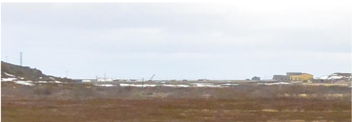
Figur 19 viser bygget fra sørvest der den visuelle endringen som følger av trafobygget blir liten, ettersom bygget dels ligger skjult for og dels skjuler eksisterende bygninger.
