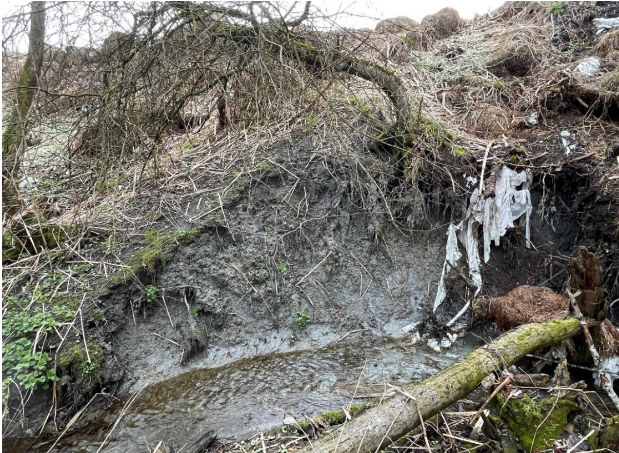
Figur 6: Bilde fra nordside av ravine ved lokasjon 3 markert i figur 1. Noe erosjon i form av overflateutglidning.
