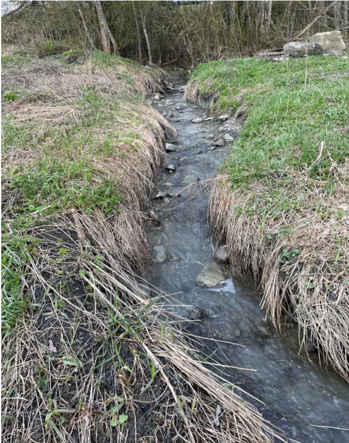
Figur 18: Bilde fra lokasjon 2 markert i figur 14. Grumsete vann. Litt erosjon.
