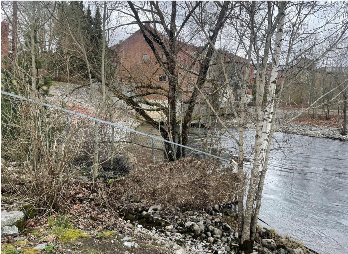
Figur 31: Langs Vestfosselva sett mot Vestfossen kraftverk. (lokasjon 1 på figur 30). Ikke erosjon.
