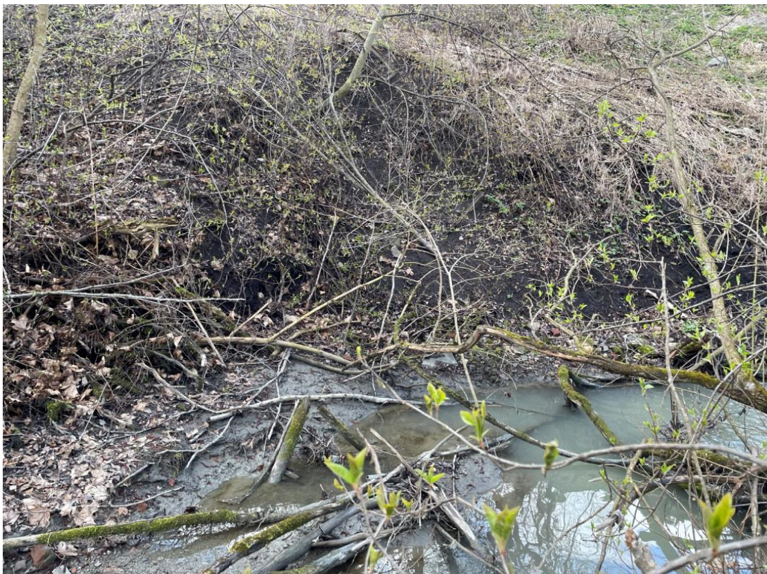
Figur 20: Bilde fra lokasjon 4 markert i figur 14. Sår i terrenget. Eksponert silt/leire i bekkebunn, grått vann. Noe erosjon.
