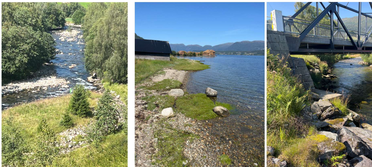
Figur 3: Bilder fra befaring, til venstre: elva mot vest (profil P1 og P2 i figur 4). Midten: langs sjøen/Ryggøra (profil P3 i figur 4). Til høyre: Langs elva nordre delen av sonen fra brua (Fv 615) sett vestover (profil P4, figur 4).
