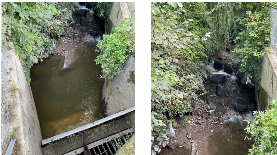
Figur 8-20 Bilder fra befaring, punkt 7
