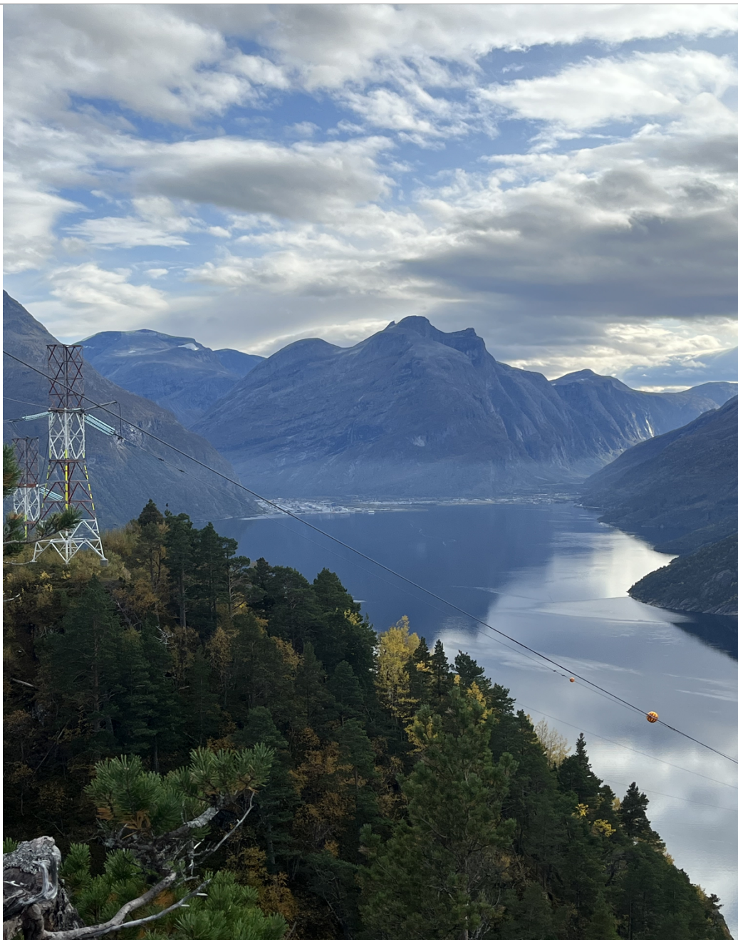
Figur 6: Fjordspennet ved Sunndalsfjorden (sett fra Karihaugen) – med luftfartsmarkering av master og liner (Kilde: NVE).
