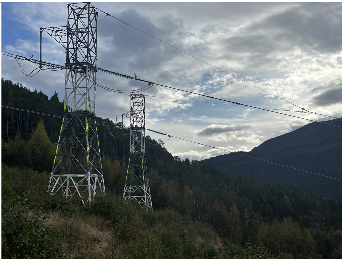
Figur 5: Eksisterende master med luftfartsmarkering ved fjordspennet over Todalsfjorden (Kilde: NVE).
