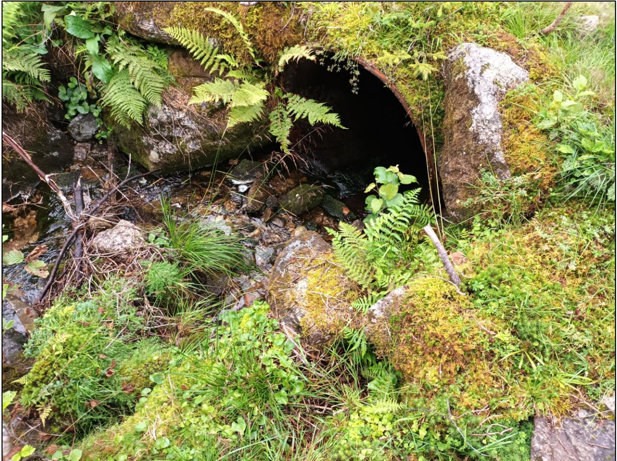
Figur 52: Drenering under veg i kulvert. Infopunkt 2.
