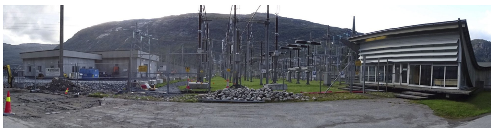
Røldal kraftstasjon: Til venstre ser ein det nye kontrollhuset. Foto: Sondof Rabbe/Privat
