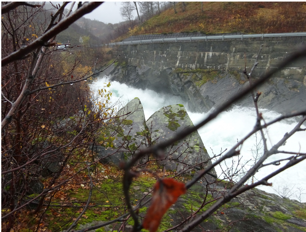
Innløp tunell under E134 – 14.10.18
