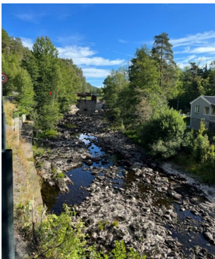
Figur 10: Lav vannføring nedstrøms Søndeled dam den 10.08.2022, med åpen bunnluke i dammen
