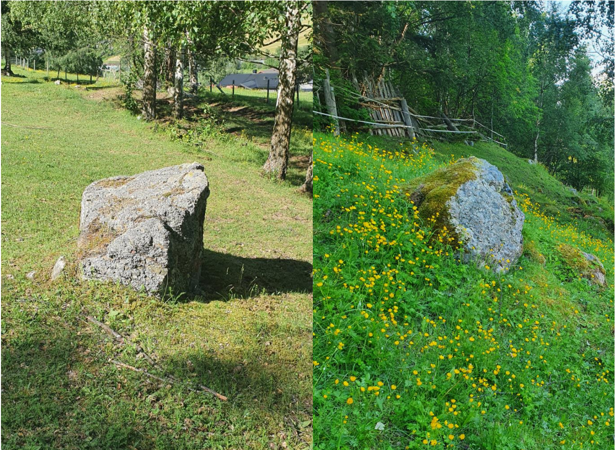
Figur 22. Flere blokker observert ovenfor bebyggelsen, men ingen ferske steinsprangblokker er observert.
