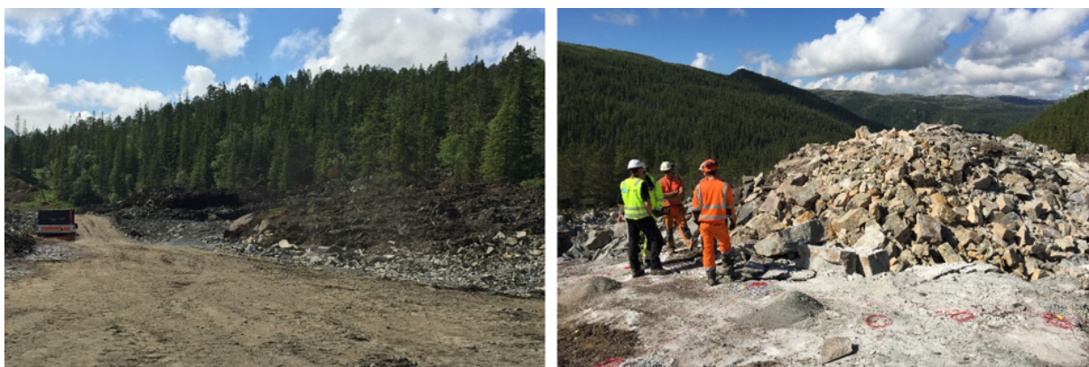
Figur 4-2 Anleggsarbeider ved nydyrking, massehåndtering og sortering av forskjellige steinstørrelse. kilde Multiconsult.
