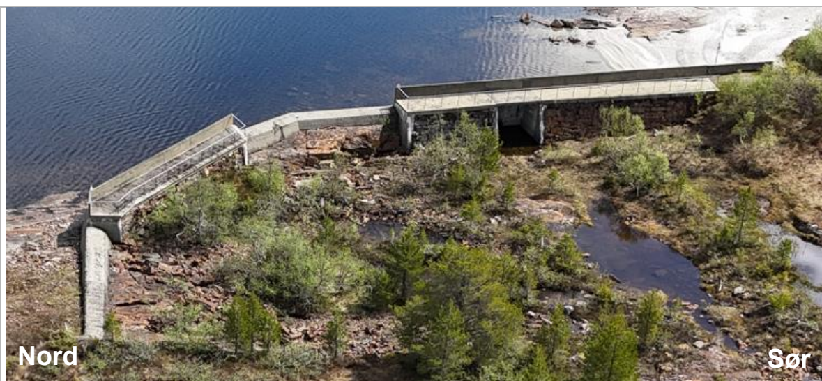
Bilde 1: Dronebilde av damkonstruksjonen tatt nedstrøms dammen. Bilde fra TrønderEnergi Kraft AS
