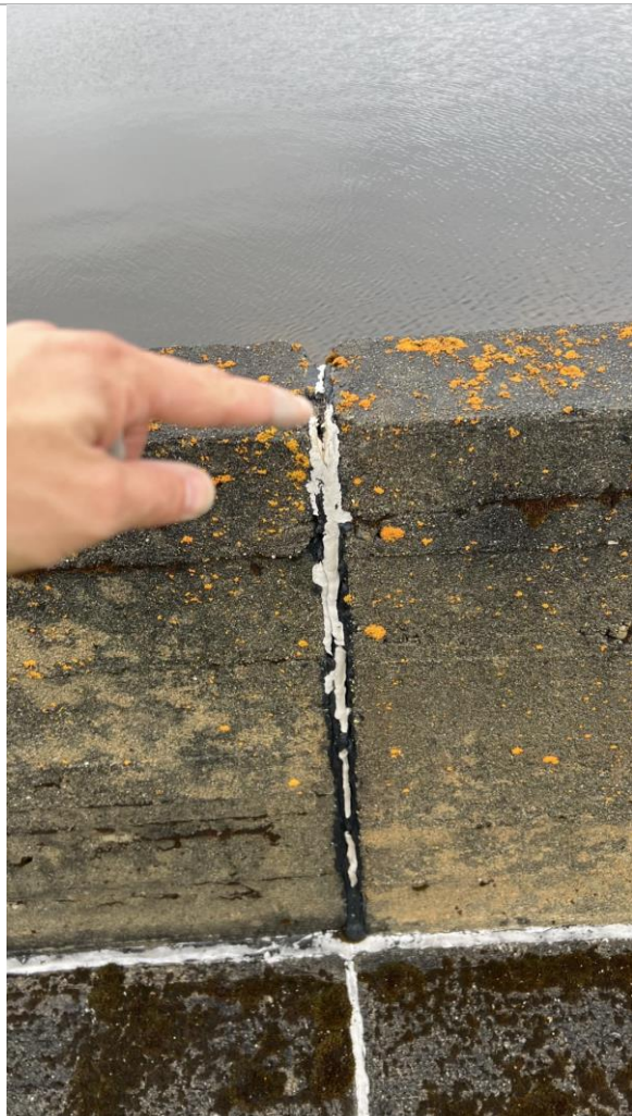
Bilde 10: Prøvepunkt F4, mellom seksjonene G og H, lys fugemasse over svart fugemasse. Prøven ble delt opp og den lyse delen slått sammen med prøve F3.
