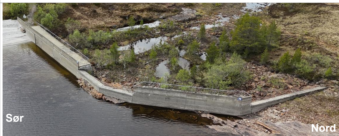
Bilde 2: Dronebilde av damkonstruksjonen tatt oppstrøms dammen. Bilde fra TrønderEnergi Kraft AS
