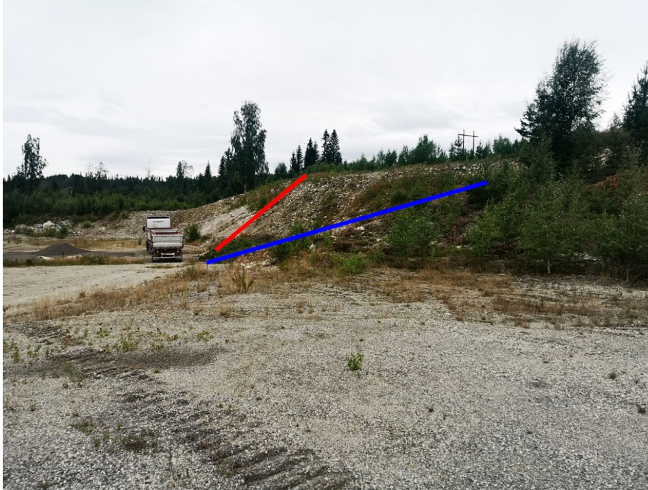
Figur 6-4: Bilde av grustaket. Her vil skråningen ned til grustaket flates ut for å redusere tap i produksjon av solenergi. Her vil skråningen (rød linje) reduseres til slik at den blir som den blå linjen. Massene vil bli fordelt utover grustaket for å oppnå jevn vinkel på underlaget også her.
