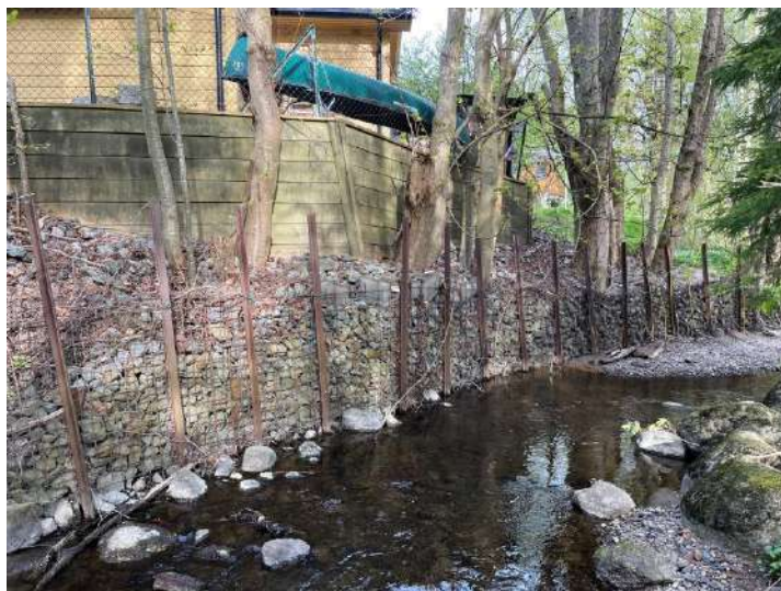
Figur 4 Punkt 2 Lokal sikring av bekkekant
