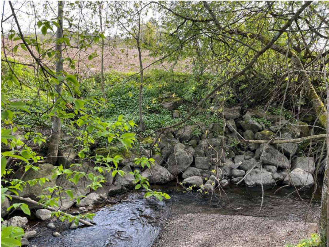
Figur 28 Punkt 18 Steinsatt yttersving mot jorde i nord, like oppstrøms kulvert under adkomstveien til nr 56
