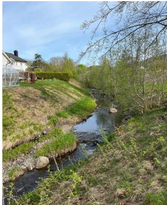
Figur 10 Punkt 8 Ser oppover bekken fra Tulipanveien 13, starten på NVEs sikringstiltak fra 2012. Ingen erosjon.
