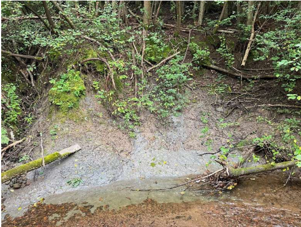
Figur 32 Punkt 20. Foto 14. august. Ingen synlige endringer siden befaringen 3. mai.
