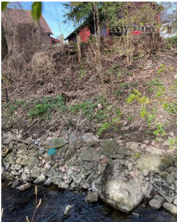
Figur 9 Punkt 7 Steinsetting hele veien langs bekken her. Noe variende kvalitet, men ingen erosjon
