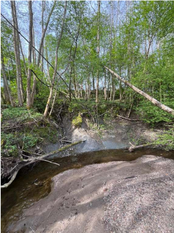
Figur 30 Punkt 20 Kraftig erosjon i høy skråning like ved Unnebergveien 56. Sidebekk som kommer ned midt i yttersvingen og medfører ytterligere erosjon.
