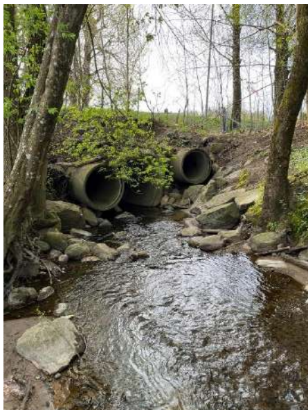
Figur 3 Punkt 1 Kulvert under Råstadveien hindrer bunnsenkning
