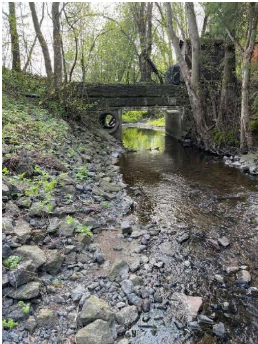
Figur 6 Punkt 4 Ser nedover bekken, steinsatt på begge sider
