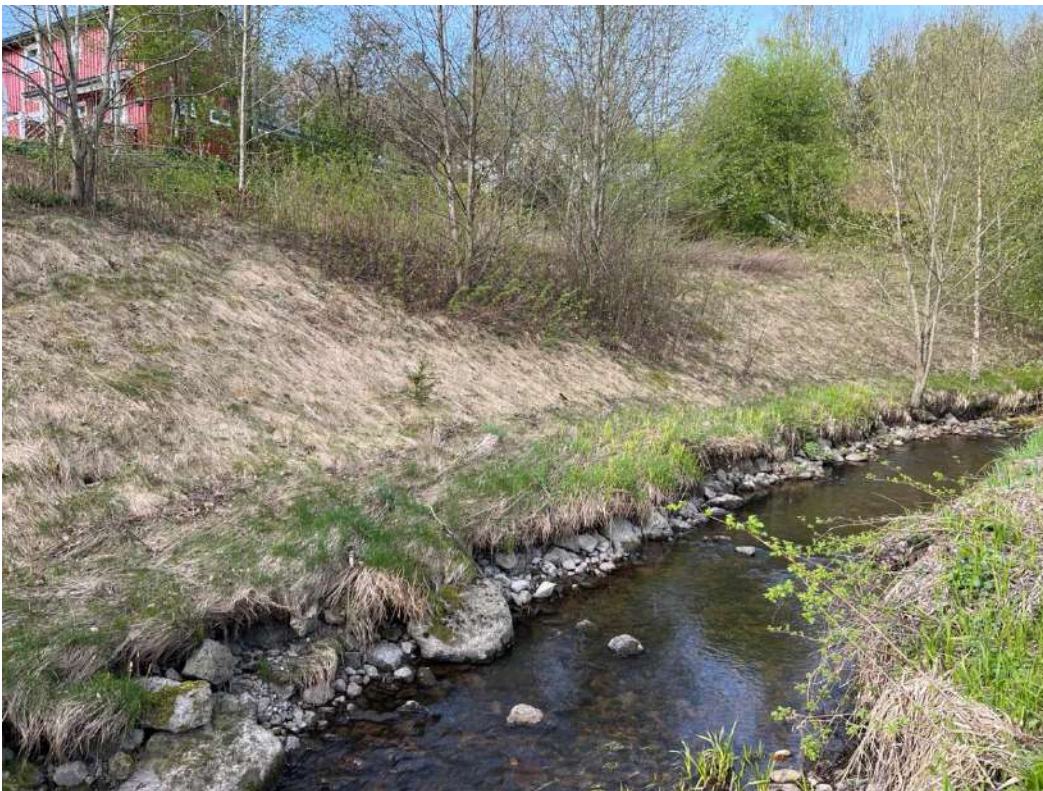
Figur 12 Punkt 10 NVEs motfylling/erosjonssikring ved Tulipanveien 18
