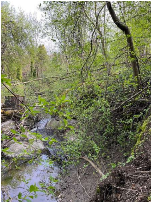
Figur 26 Punkt 16 Like oppstrøms fjellterskelen er det erosjon mot sør
