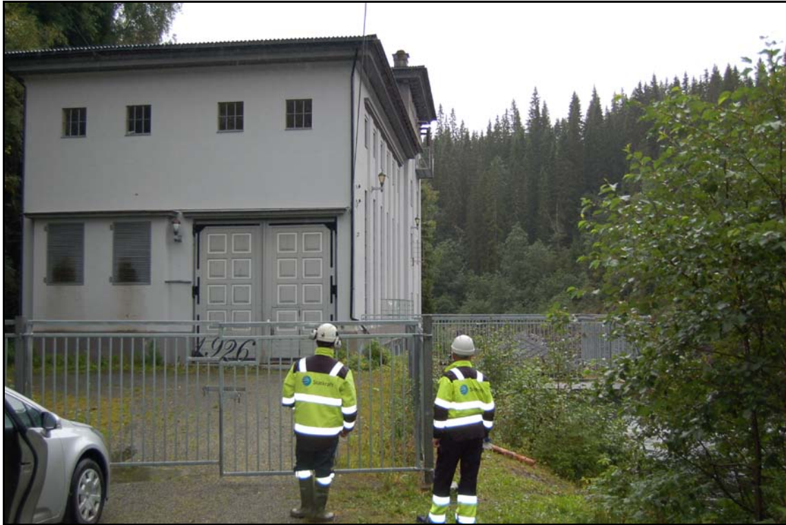
Løkaunet kraftverk fra 1925
